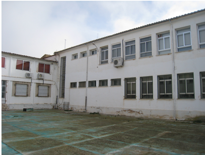
Figura 10: Fachada NO. Fuente: propia
