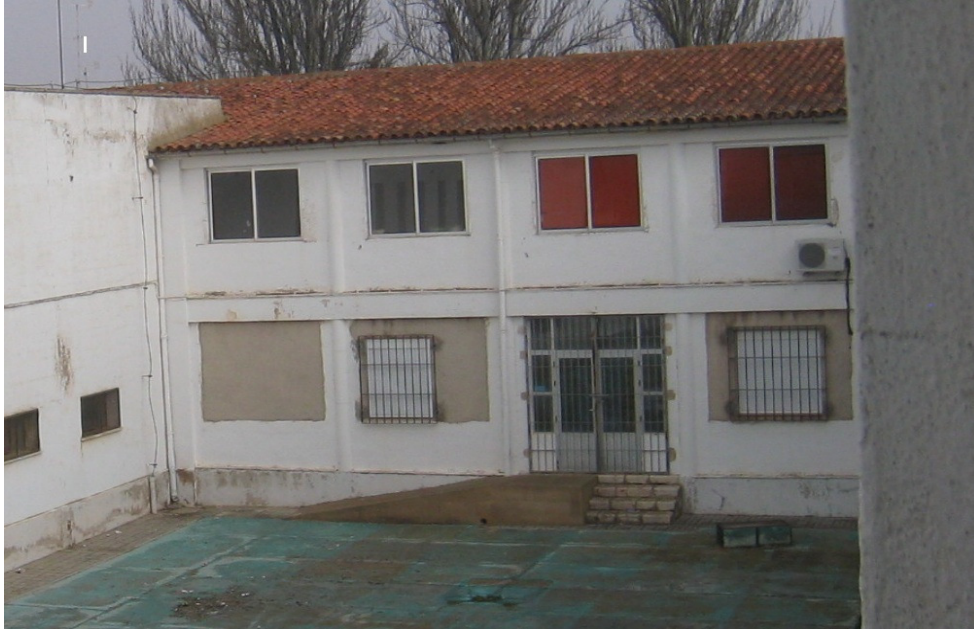
Figura 14: Fachada SO donde se puede observar el tipo de cubierta.
