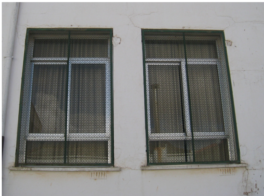
Figura 16: Carpintería exterior en Planta Baja. Fuente: propia
