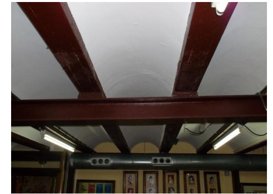
Correas modificadas. Forjado Planta Baja.
