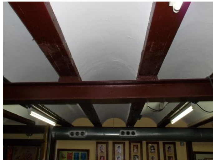
Correas modificadas. Forjado Planta Baja.
