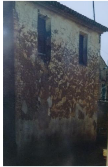
Alquería Casa Suro. Fachada Oeste.
