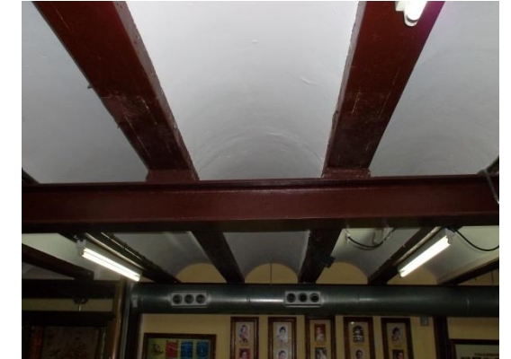
Forjado Planta baja. Correas.
