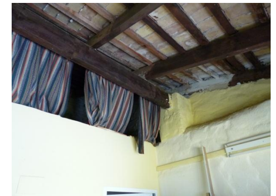
Vigas cargadoras. Volumen Planta Baja.
