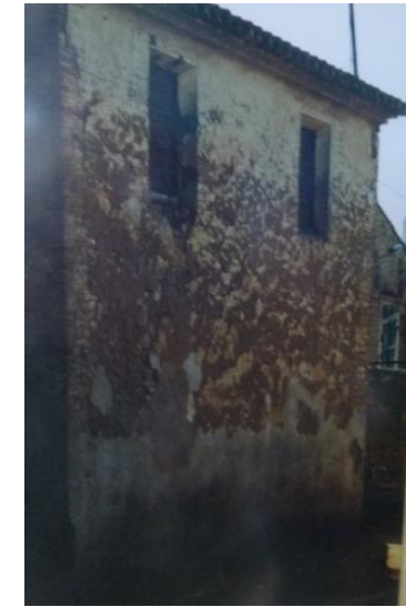
Alquería Casa Suro. Fachada Oeste.
