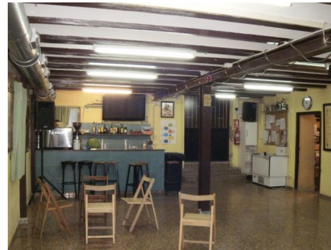
Refuerzo estructural. Forjado Planta Baja.
