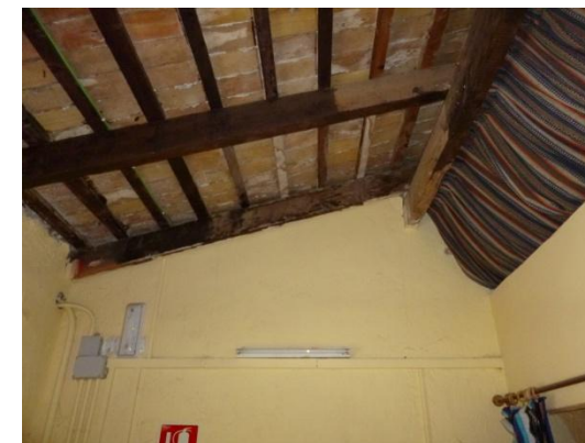
Vigas cargadoras. Volumen Planta Baja.
