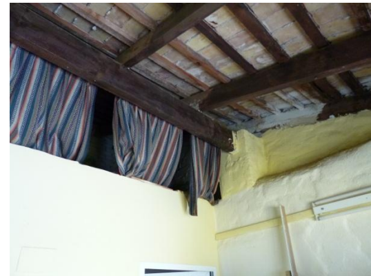
Vigas cargadoras. Volumen Planta Baja.
