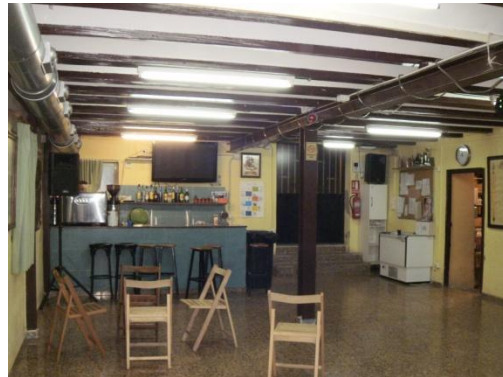
Refuerzo estructural. Forjado Planta Baja.
