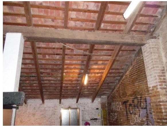
Vigas cargadoras. Volumen Planta Primera.
