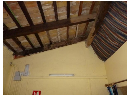
Vigas cargadoras. Volumen Planta Baja.
