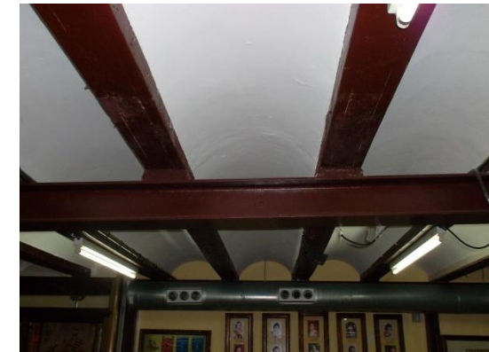
Forjado Planta baja. Correas.
