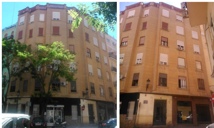
Ilustración.36 y 37. Vila Prades 24 Fuente: Edición propia
