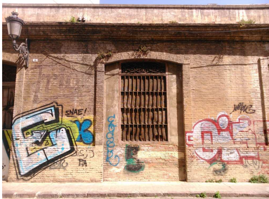
Ilustración.75.Organismos vegetales en cornisa y arranque de fachada. Fuente: Edición propia
