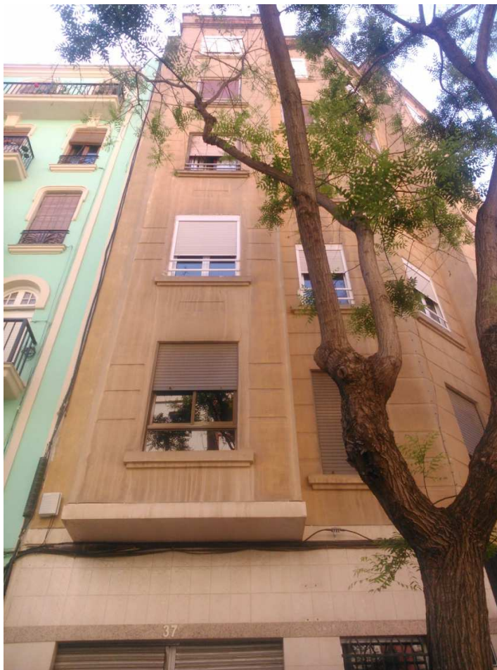
Ilustración.66.Lavado por humedad. Fuente: Edición propia
