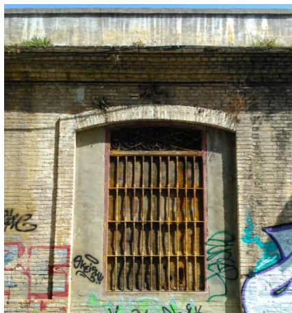
Ilustración.74. Oxidación electroquímica. Fuente: Edición propia
