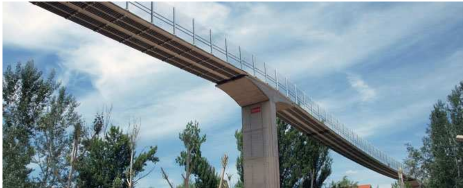
Fotografía 11: Puente de acciona en cuenca sobre el río Júcar.2012
