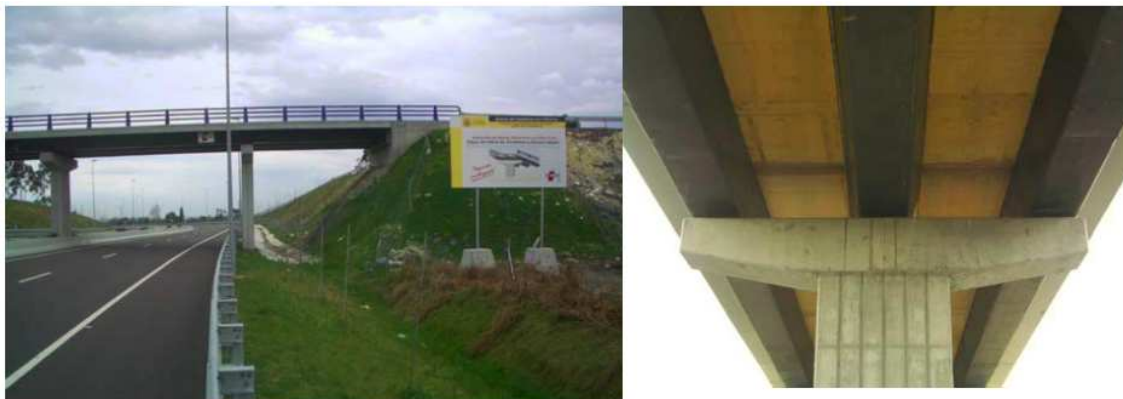
Fotografía 1: Primer puente de materiales compuestos construido en España (2004)
