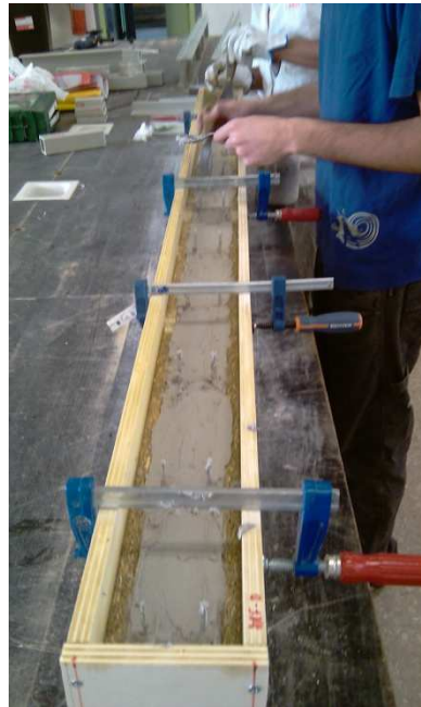
Fotografía 33: Colocación de la resina epoxi previa al hormigonado.
