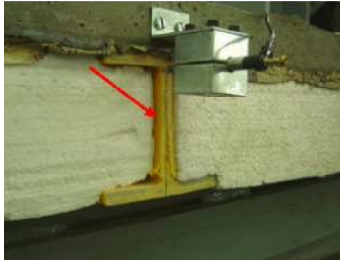
Figura 33: Perfil en I, rotura alma por cortante [6].
