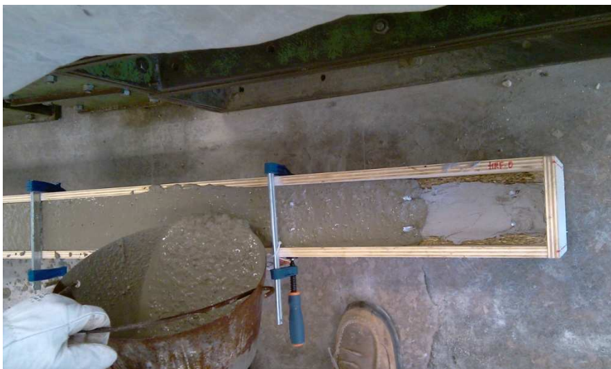
Fotografía 34: Hormigonado de las vigas híbridas.
