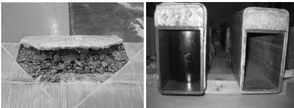
Fotografía 7: Aplastamiento del hormigón por esfuerzos normales.[14]
