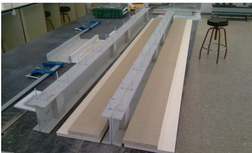
Fotografía 41: Perfil IPE-120 con conectores en el ala y alma (izquierda) y colocación de encofrado (derecha).
