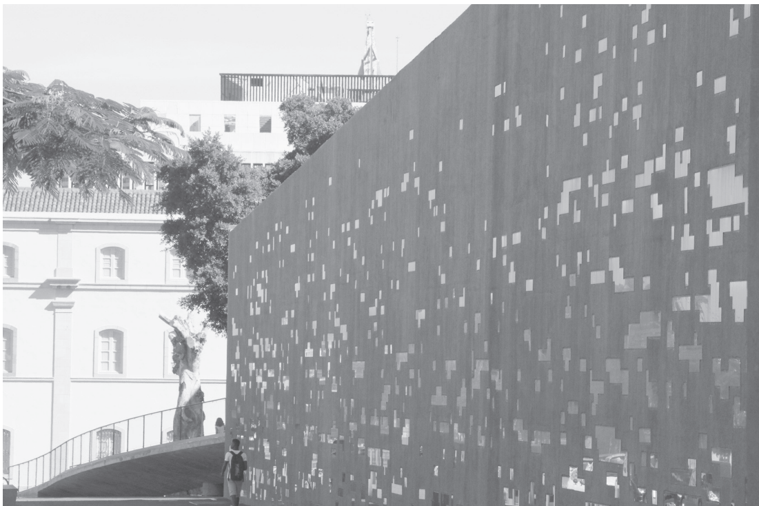
Figure 5. Tenerife Espacio de las Artes (TEA) designed by Herzog & de Meuron.
