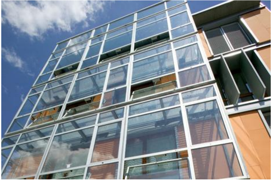
Figura 15. Doble invernadero del ecoedificio de la Vola. 2008. Construible.es.
