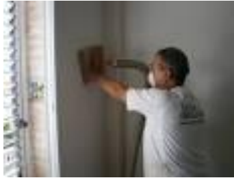
Figura 11. Aislamiento mediante insuflado. 2014.spaininsulation.com.
