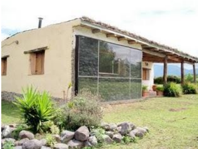
Figura 14. Muro Trombe en casa ecológica en Tucumán. 2008. ecofactory.blogspot.com.
