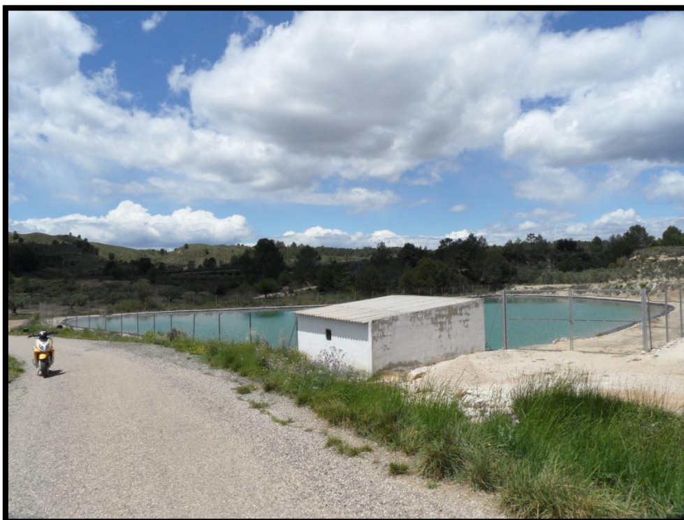
Foto 4: Depósito de riego en los baños.
