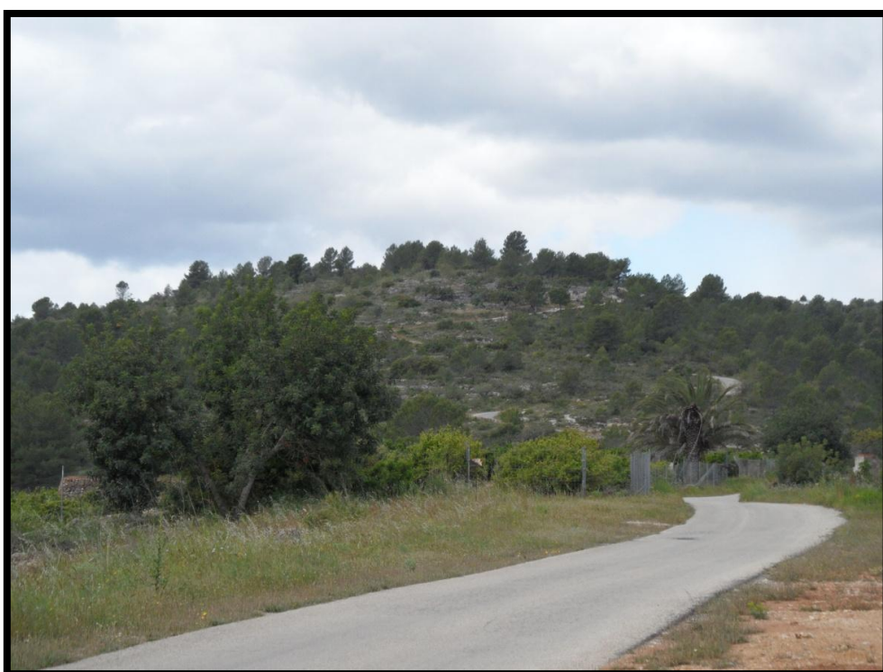
Foto 19: Subida del Carril. A la izquierda queda el barranco de “El Abrullador”
