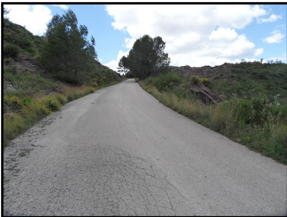
Foto 2: Subida al Terrero.
