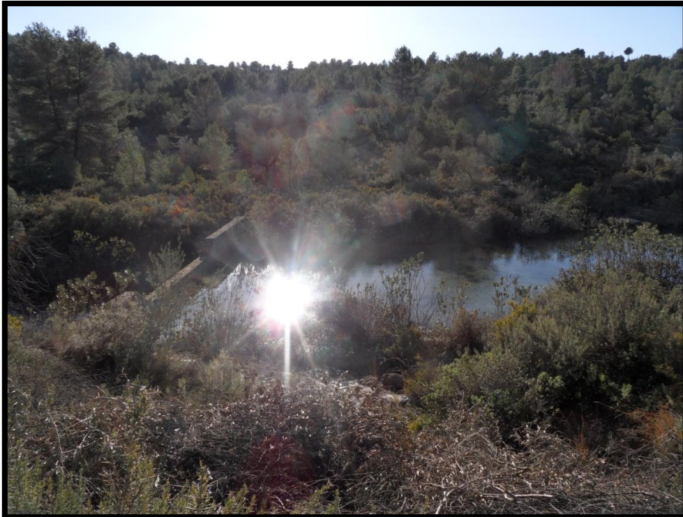
Foto 29: Dique del Barranco de “El Abrullador”.
