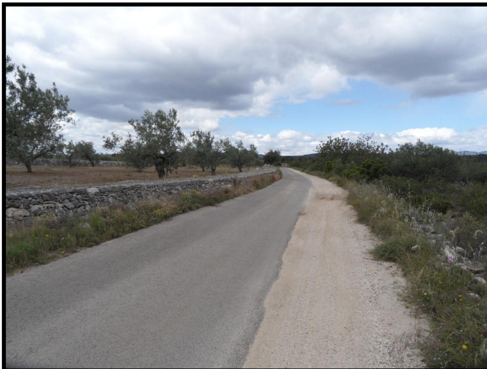
Foto 21: Pista del Carril, tramo asfaltado.
