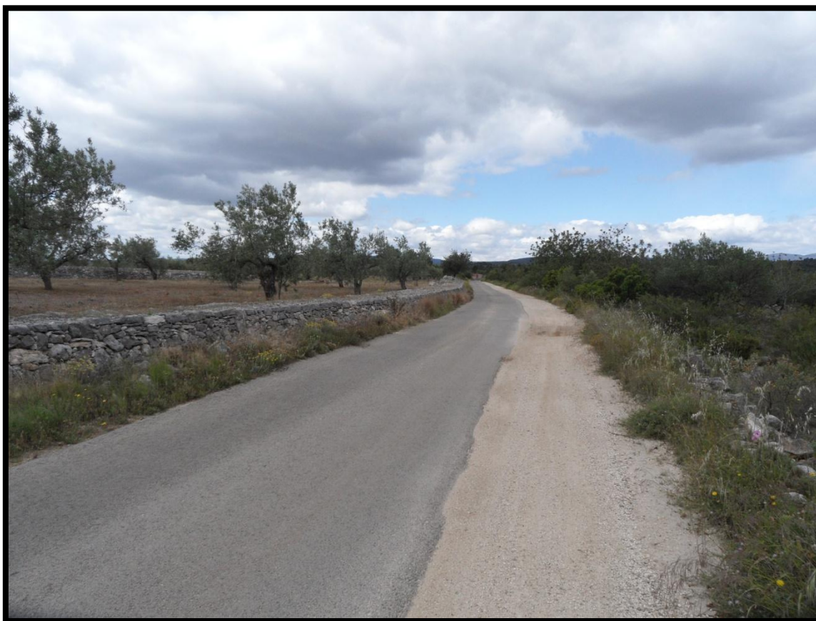
Imagen 6.1: Pista del carril, tramo con zona asfaltada.
