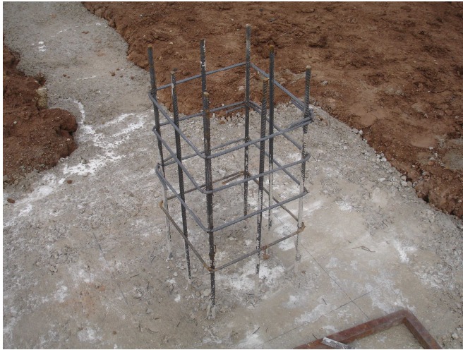
Foto 6. Replanteo de enanos. 2014. Fuente: Elaboración propia.
