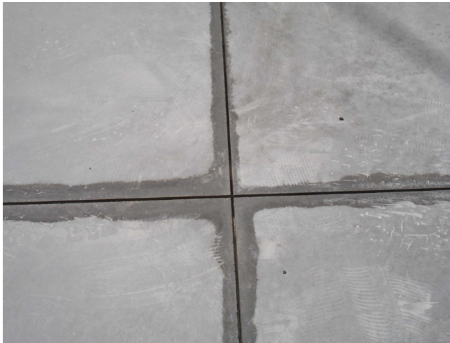
Foto 23. Juntas de dilatación. 2014. Fuente: Elaboración propia.
