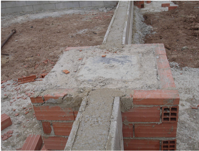
Foto 11. Muretes hormigonados. 2014. Fuente: Elaboración propia.
