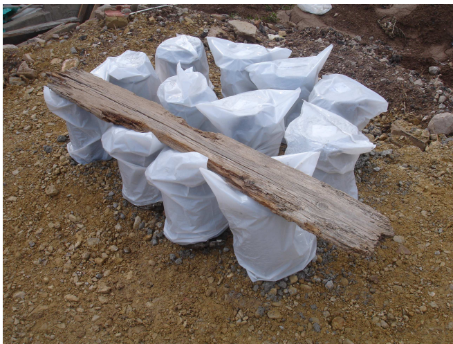
Foto 5. Probetas del hormigón de la cimentación. 2014. Fuente: Elaboración propia.
