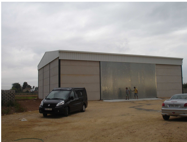
Foto 25. Nave terminada. 2014. Fuente: Elaboración propia.
