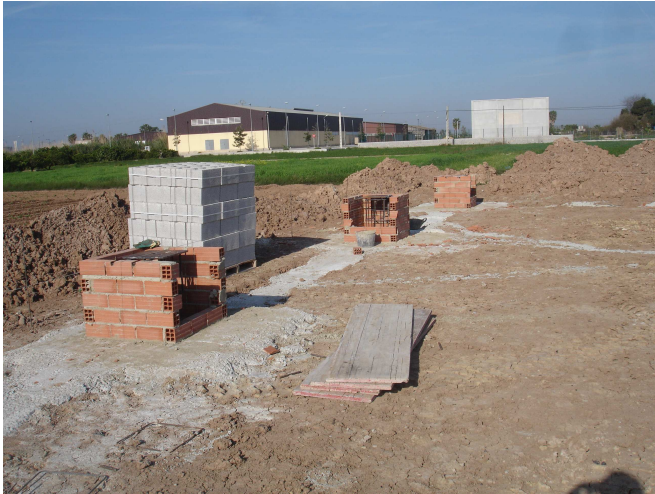
Foto 8. Vista general de encofrado de enanos de hormigón. 2014. Fuente: Elaboración propia.
