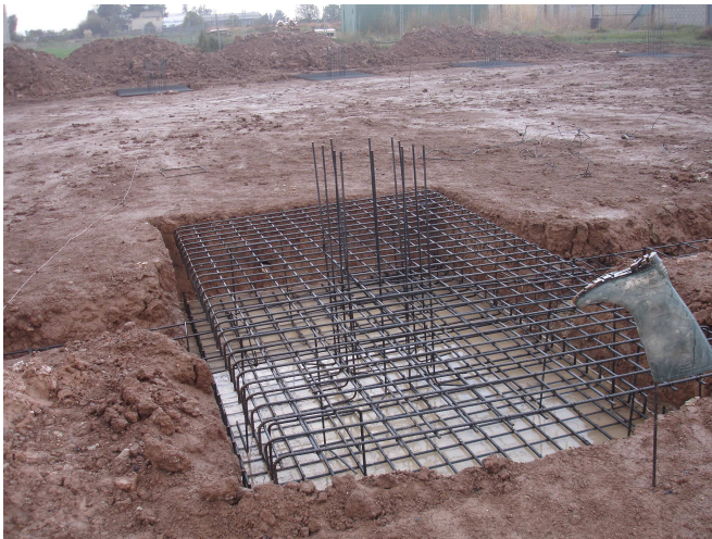
Foto 3. Armado de zapata. 2014. Fuente: Elaboración propia.
