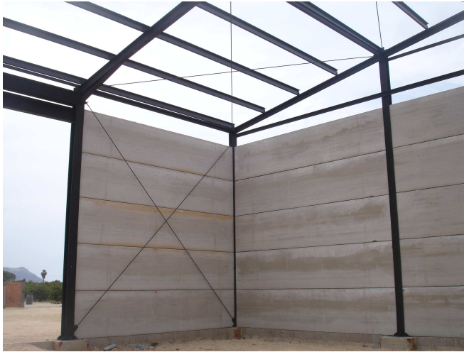
Foto 19. Montaje estructura metálica. Correas cubierta. 2014. Fuente: Elaboración propia.
