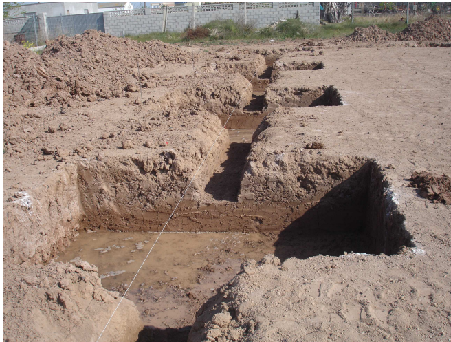
Foto 2. Excavación cimentación. 2014. Fuente: Elaboración propia.
