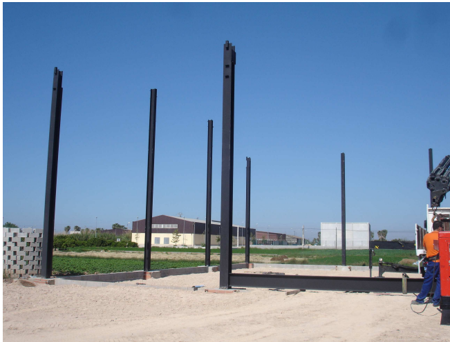
Foto 13. Montaje de pilares metálicos. 2014. Fuente: Elaboración propia
