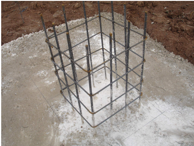
Foto 7. Replanteo de enanos. 2014. Fuente: Elaboración propia.
