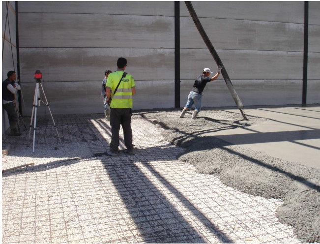
Foto 22. Formación de solera. 2014. Fuente: Elaboración propia.
