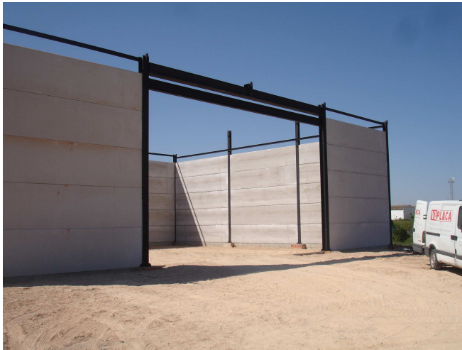
Foto 14. Montaje de paneles. 2014. Fuente: Elaboración propia.
