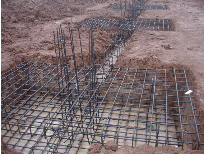
Foto 4. Armado zapata y viga de atado. 2014. Fuente: Elaboración propia.
