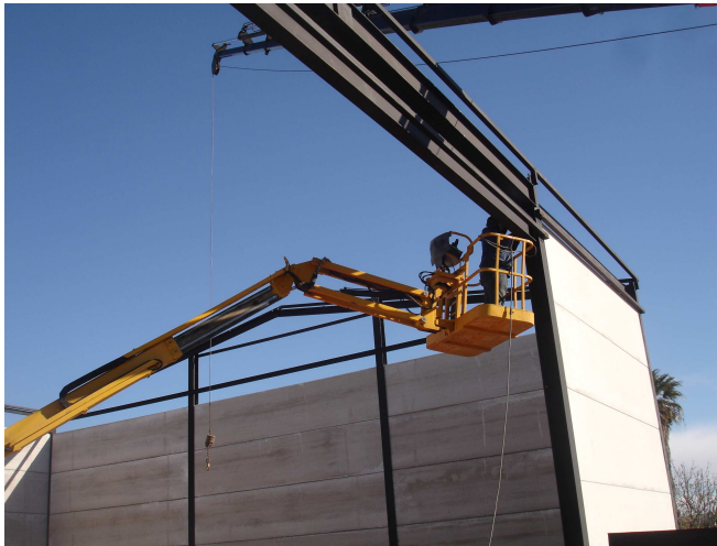
Foto 18. Montaje de estructura. 2014. Fuente: Elaboración propia.
