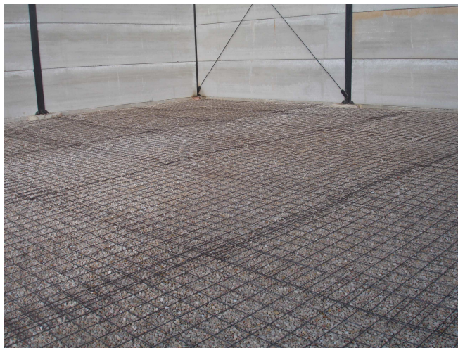
Foto 21. Relleno de grava y mallazo. 2014. Fuente: Elaboración propia.
