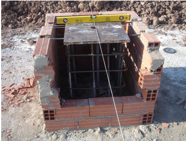
Foto 9. Detalle encofrado enano y comprobación replanteo. 2014. Fuente: Elaboración propia.
