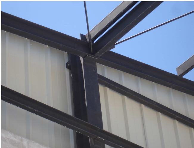
Foto 20. Montaje cerramiento vertical y subestructura. 2014. Fuente: Elaboración propia.
