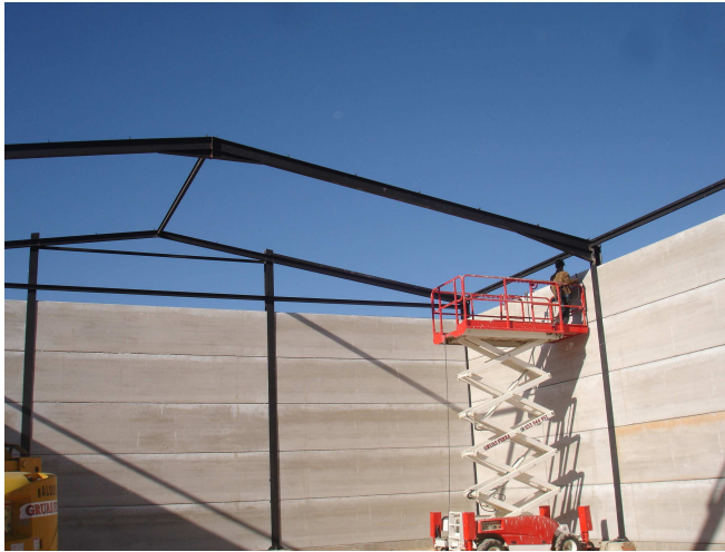
Foto 17. Montaje de estructura. 2014. Fuente: Elaboración propia.
