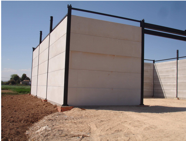
Foto 15. Montaje de paneles. 2014. Fuente: Elaboración propia.
