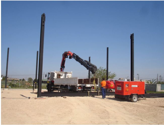
Foto 12. Montaje de pilares metálicos. 2014. Fuente: Elaboración propia.
