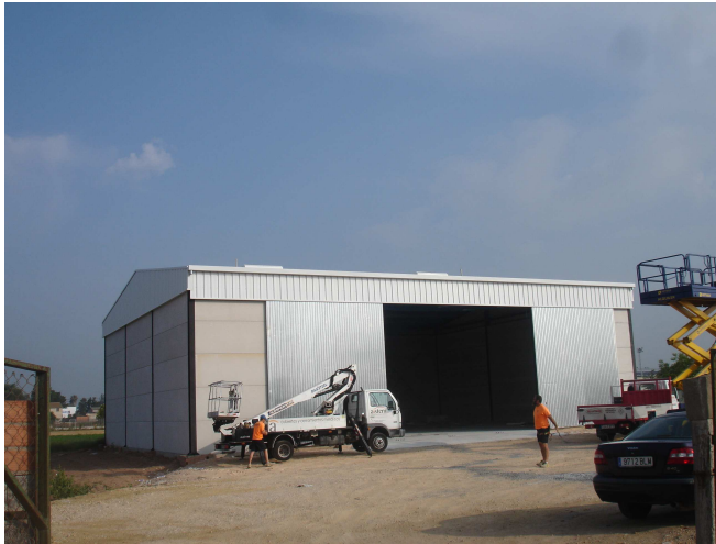
Foto 24. Cubierta terminada. 2014. Fuente: Elaboración propia.
