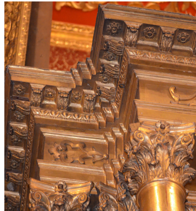
Imagen 34. Cornisa acodillada ornamentada en su parte inferior.
