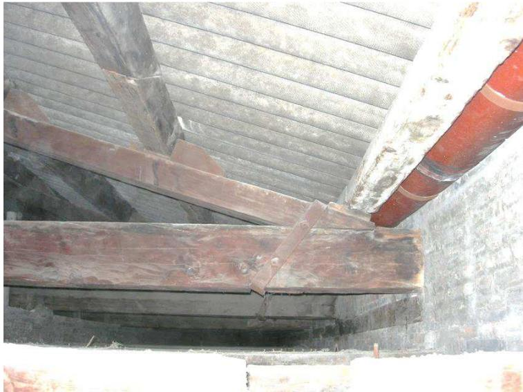
**FIGURA 43.** *Apoyo de la cubierta con el muro portante. Estación del Grao. 2005. Francisco Taberner Pastor.*
