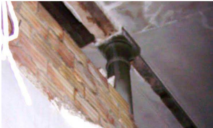
**FIGURA 34.** *Nudo pilar con entramado de madera. Enero 2013.*
