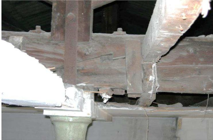
**FIGURA 33.** *Detalle nudo pilar con entramado de madera. Estación del Grao. 2005. Francisco Taberner Pastor.*
