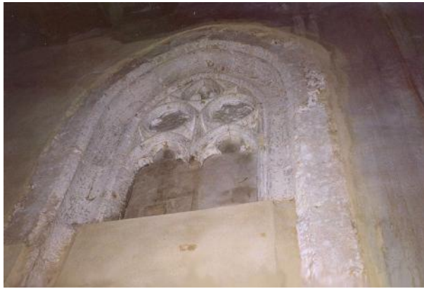
Detalle ventana de piedra de la Antigua fachada gótica, actualmente cegada.
