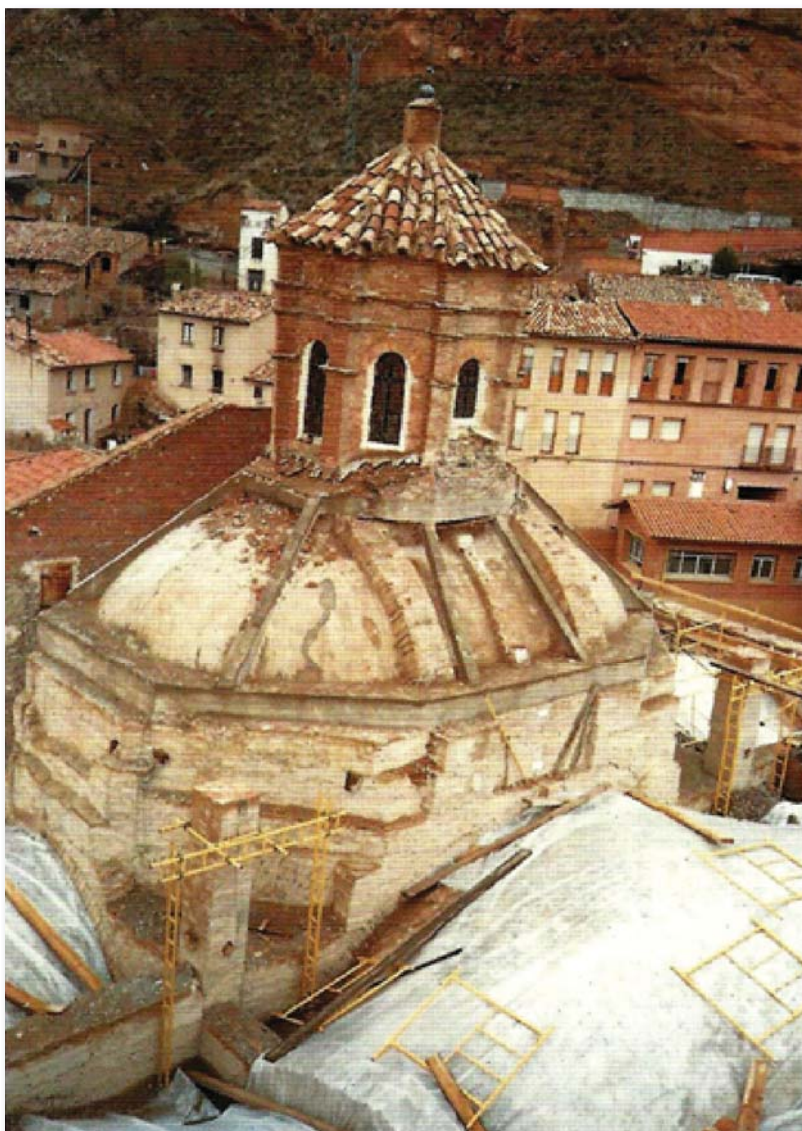
Fig. 9 Címborrio y linterna reforzadas mediante doble anillo de hormigón armado zunchados entre ellos. (Foto: cuadernillo de restauración)
