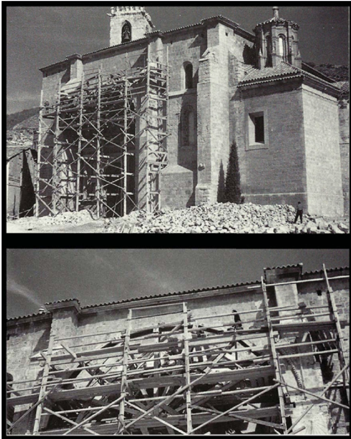
Fig. 11 Imágenes de la eliminación del tejado de la portada principal. (Foto: cuadernillo de restauración)
