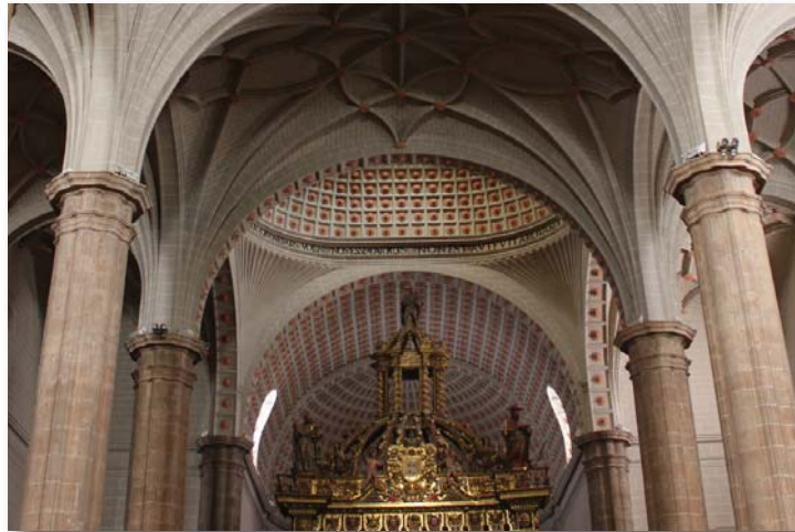
Fig. 10 Bóvedas encasetonadas del presbiterio
