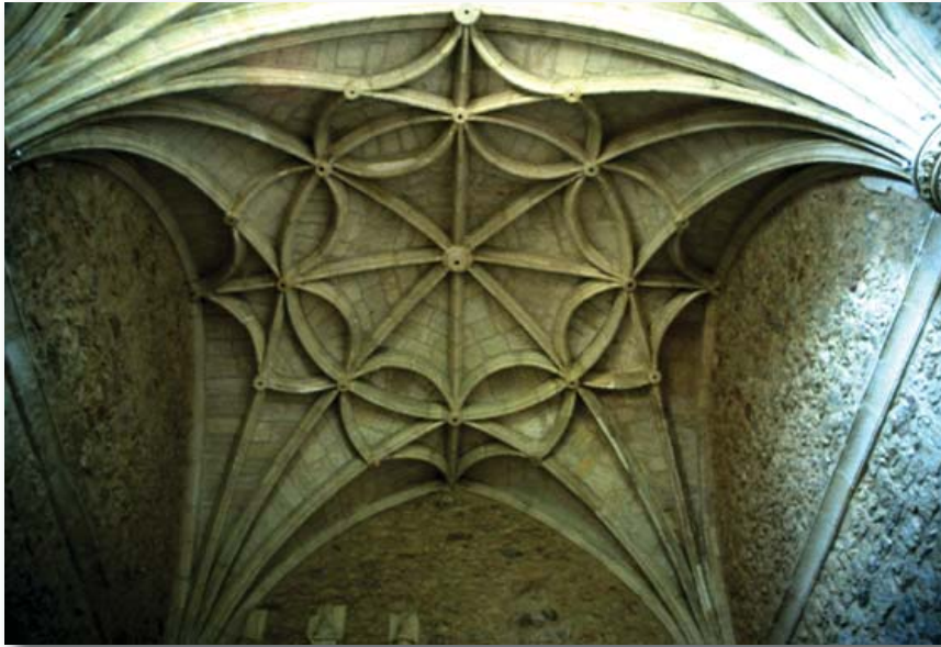
Fig. 10 Bóveda en la sacristía del monasterio del Parral, Segovia.
