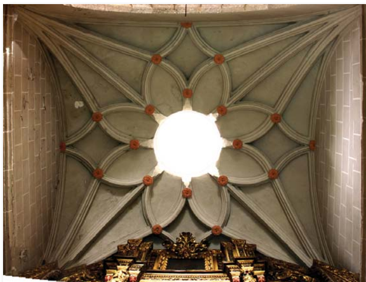
Fig. 13 Bóveda de crucería estrellada que cubre la capilla de la Soledad
