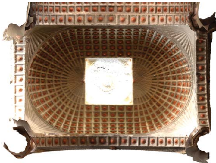
Fig. 10 Bóveda que cubre el altar mayor
