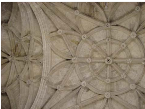
Fig. 14 Bóveda de la sacristía de los Cálices de la catedral de Sevilla, atribuida a Diego de Riaño
