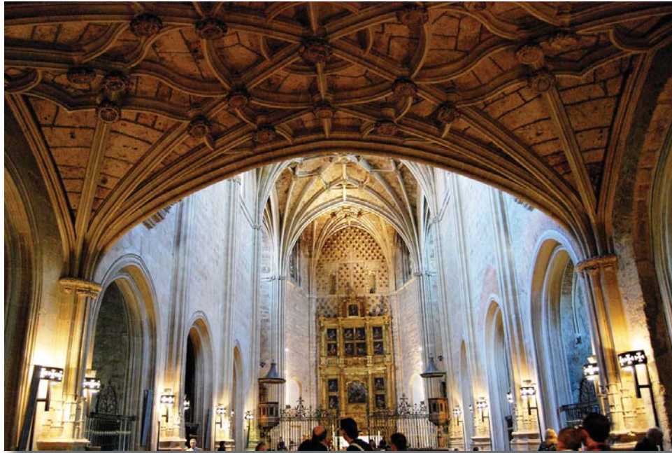
Fig. 12 Bóveda plana bajo el sotocoro del antiguo hospital de San Marcos, León. Obra de Juan Guas
