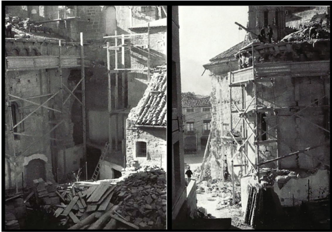
Fig. 12 Imágenes de la intervención de la recuperación del ábside románico. (Foto: cuadernillo de restauración)
