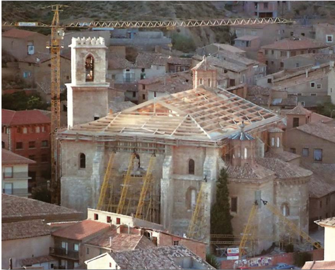
Fig. 19 Estructura de madera laminada formando la nueva cubierta (Foto: cuadernillo de restauración)
