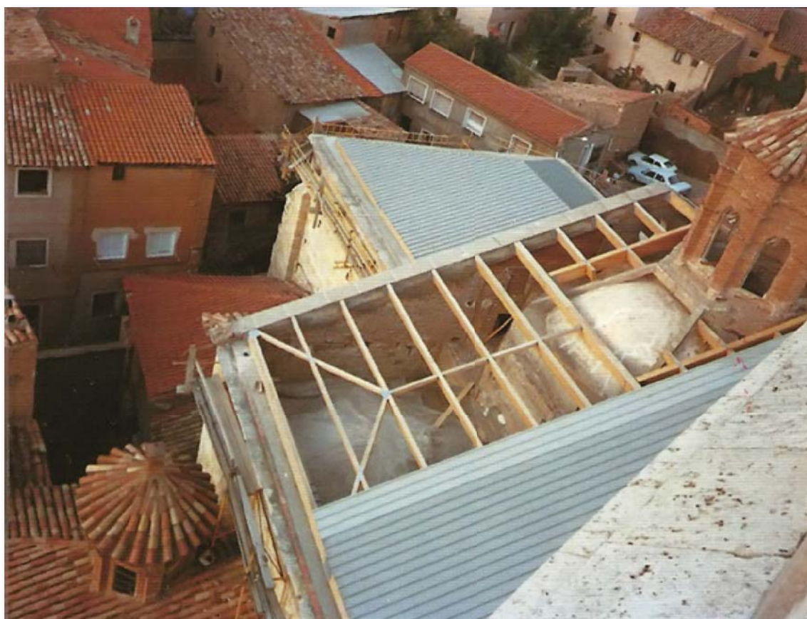
Fig. 20 Tablero de chapa lacada sobre la estructura de madera laminada (Foto: cuadernillo de restauración)
