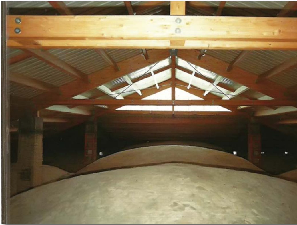
Fig. 21 Detalle de la estructura de madera laminada, desde el extradós de las bóvedas
