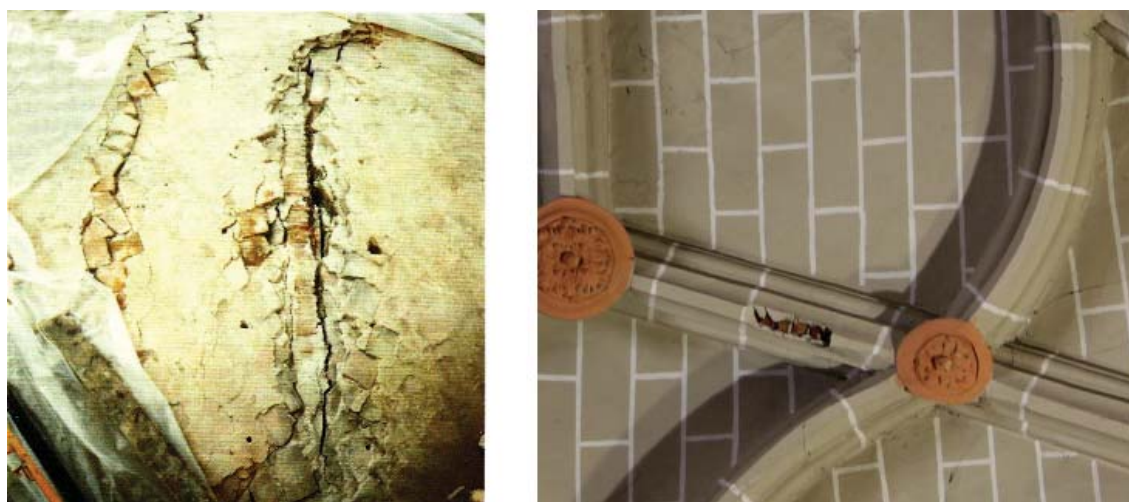
Fig. 65 Extradós e intradós de la bóveda lateral izquierda, donde vemos como están contruídos los nervios
