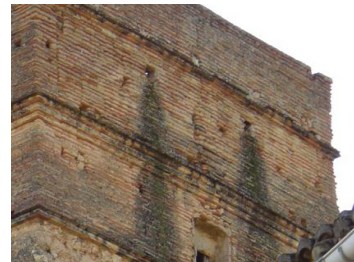
Floridures, despreniments, esquerdes i erosió mecànica
