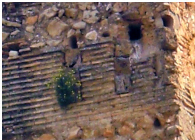
Vegetació superior en la façana Oest, cota +18m
