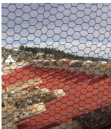
Intervenció i element impropri. Xapa metàl·lica
