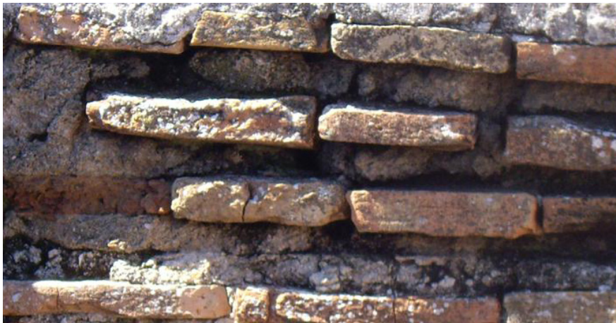
Buidat de juntes en l'ampit, vist des de l'interior del mur Sud
