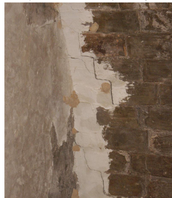
Esquerda en la volta de la planta segona
