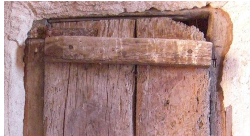
Marques de corc en la porta de l'escala. Planta segona
