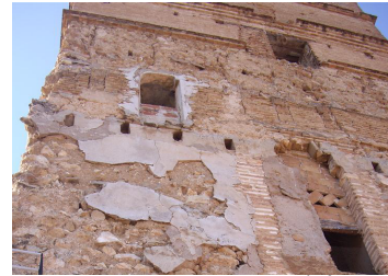
1. Intervencions, revestiments, erosió i fissures
