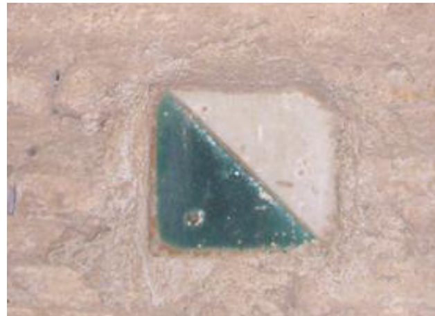
Fragments de ceràmica vidriada "de mocador" de 11 x 11cm en la planta tercera, mur Oest.
