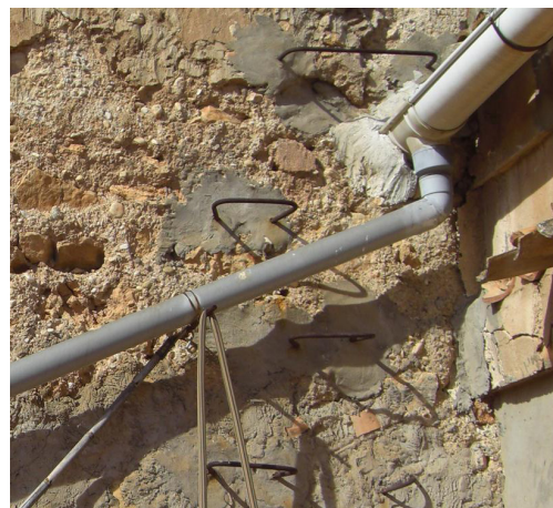
Elements metàl·lics, canaló i baixant de PVC en la façana Est. Xapa metàl·lica en la coberta
