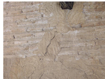
Esquerda en la fàbrica
