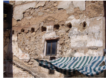
ntervencions, revestiments, elements impropis, erosió i fissures
