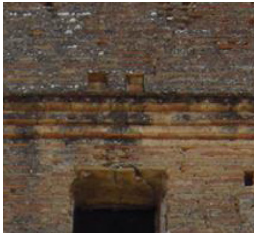
Llavat diferencial. Cornisa del primer cos de rajola de la façana Nord
