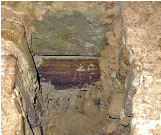
Anidament de vespes i excrements d'aus. Planta tercera en el mur interior, orientació Est
