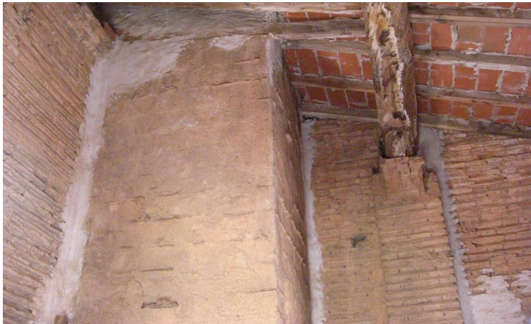
Diferents rejuntats en la planta tercera
