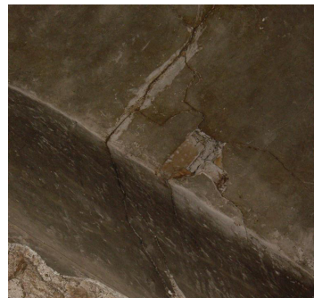
Esquerda en la volta de la planta primera
