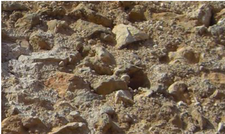
Mostra de la tàpia de la torre d'Antella del parament de la façana Est
