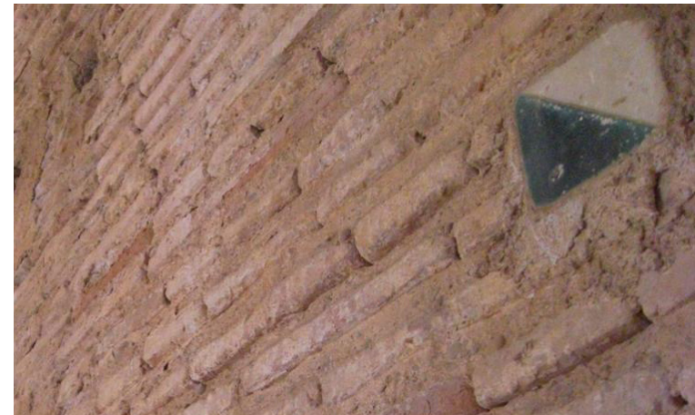
Parament interior del mur de rajola, façana Oest
