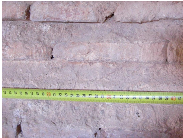
Mostra dels rajols dels murs
