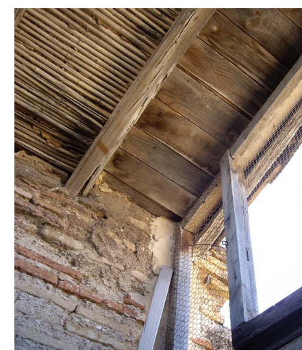
Intervenció. Coberta de l'escala
