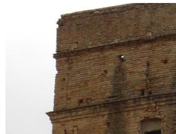
Esquerdes, despreniments i buidat de juntes
