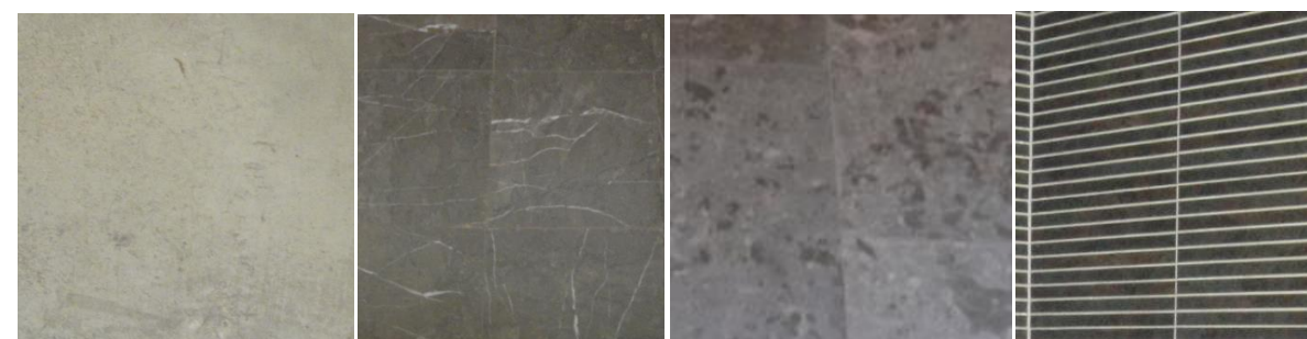
Figura 60: Solados y alicatados de nueva colocación.
