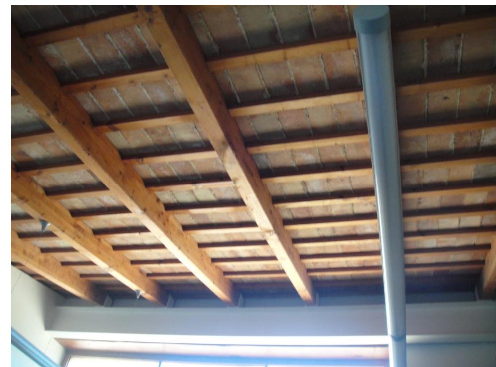
Figura 78: Estructura del tejado en altillo. Fuente propia.
