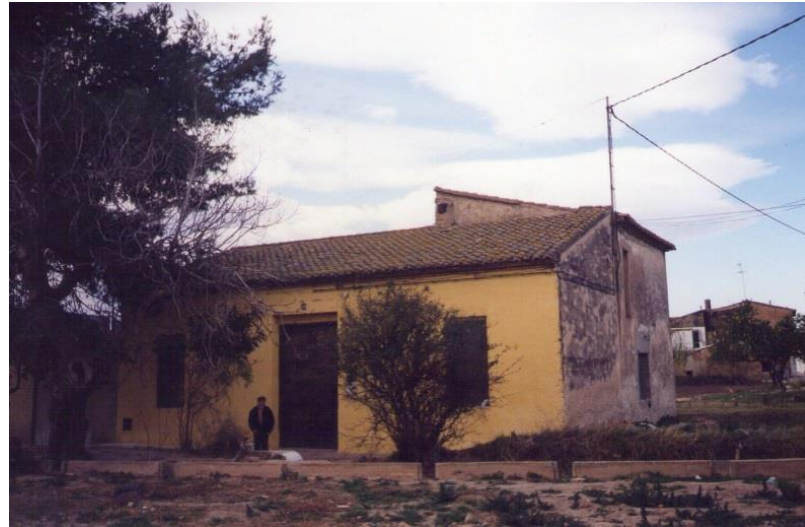
Figura 70: Alquería Benlloch, años 90. Fuente: Carmen Cárcel.
