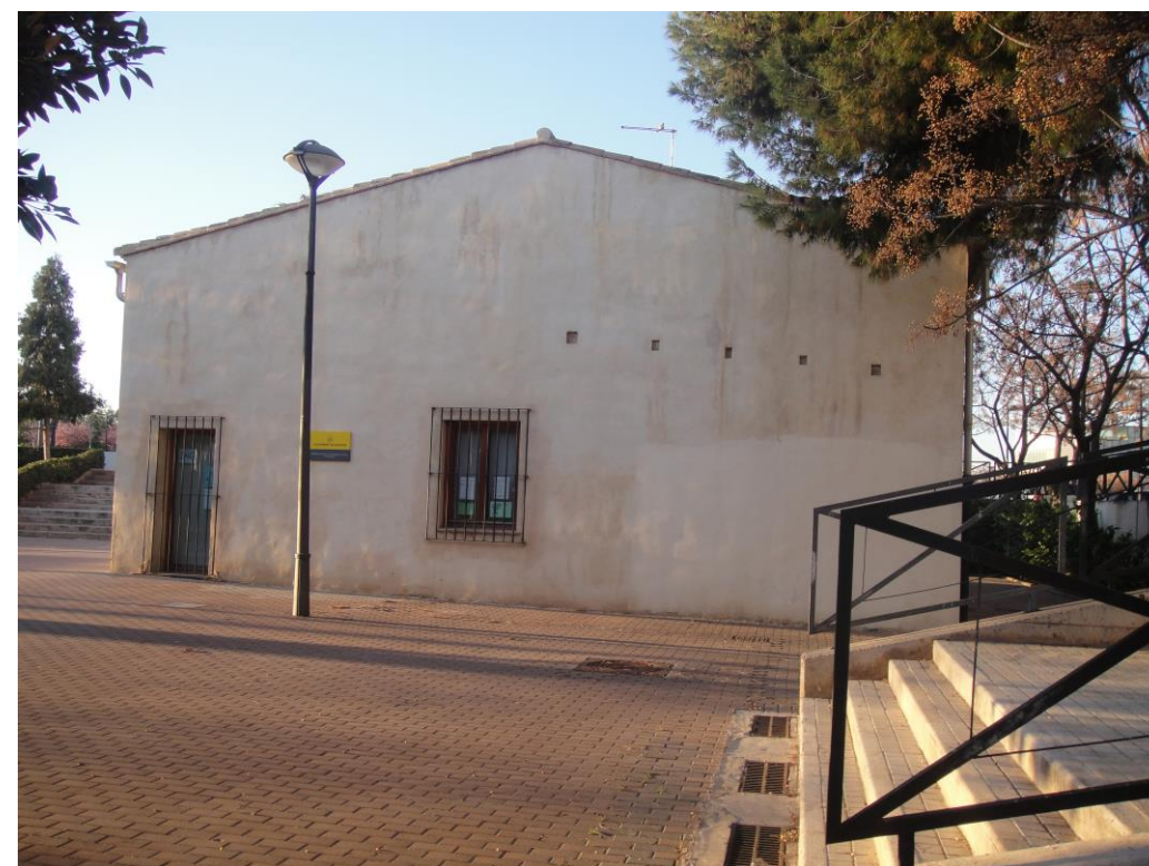
Figura 73: Fachada sur. Fuente propia.
