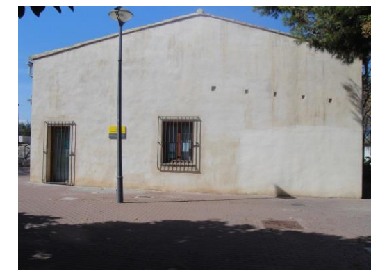
Figura 59: Cubierta a dos aguas de la fachada sur. Fuente propia
