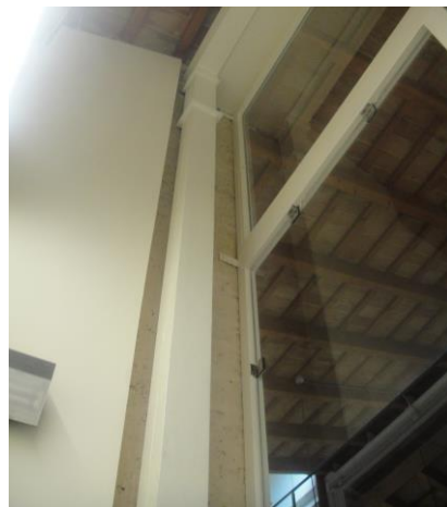
Figura 56: Pilar y viga de apoyo intermedio. Fuente propia
