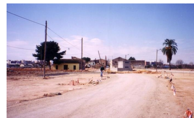
Figura 53: Alquería Benlloch a la izquierda de la imagen durante el proceso urbanizador. Fuente: Carmen Cárcel García
