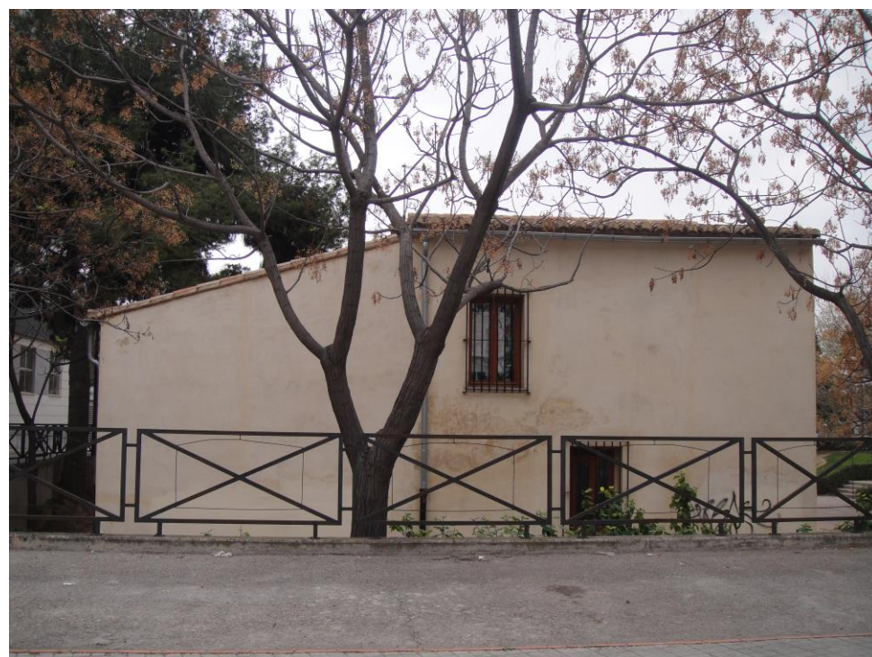
Figura 74: Fachada norte. Fuente propia.
