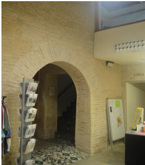
Figura 54: Arco en muro. Fuente propia.
