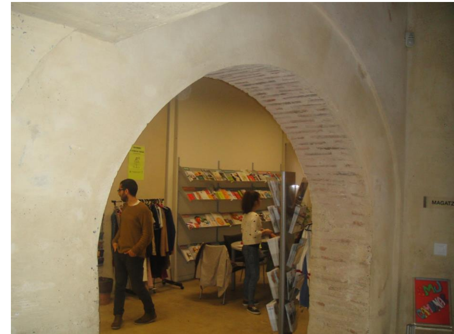
Figura 81: Arco en entrada principal. Fuente propia.
