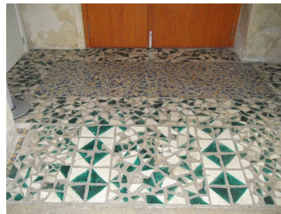
Figura 61: Mosaico a modo de trencadís en la entrada principal. Fuente propia
