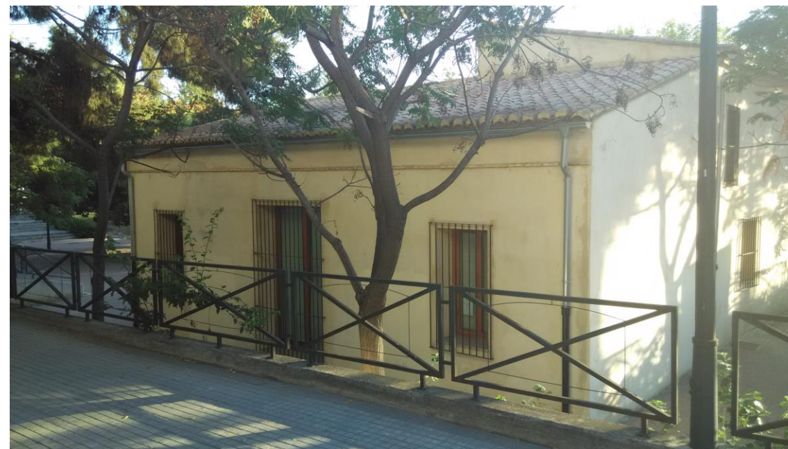
Figura 75: Fachada este. Fuente propia.
