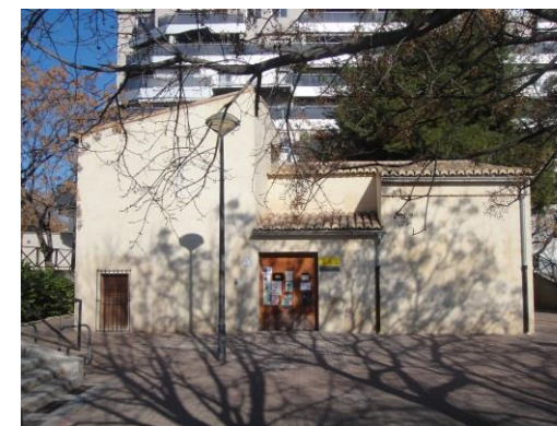
Figura 58: Vista de las cubiertas de la fachada oeste. Fuente propia
