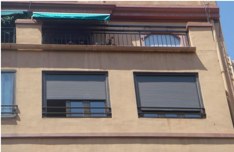
Figura 40. Ensuciamiento por lavado diferencial.2014. Fuente propia.
