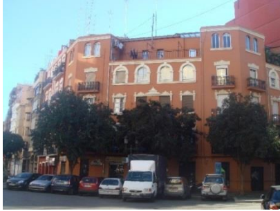
Figura 27. Edificio tipología 2. 2014. Fuente propia.
