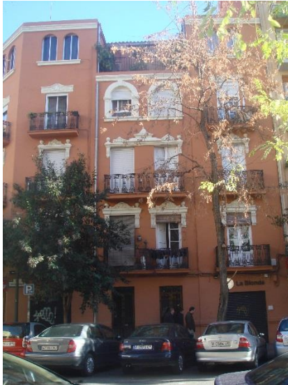
Figura 18. Ejemplo edificio de muro aparejado. 2014. Fuente Propia
