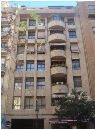
Figura 29. Edificio tipología 4. 2014. Fuente propia.
