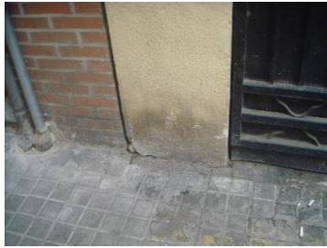
Figura 32. Junta de dilatación entre edificios .2014. Fuente propia.
