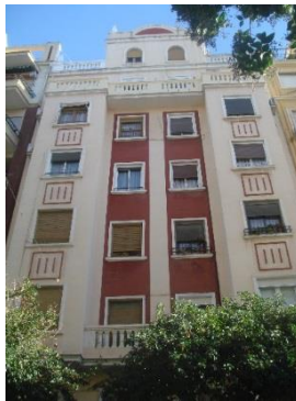
Figura 28. Edificio tipología 3. 2014. Fuente propia.
