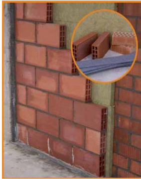
Figura 22. Hoja interior de ladrillo cerámico. 2014. Construmática
