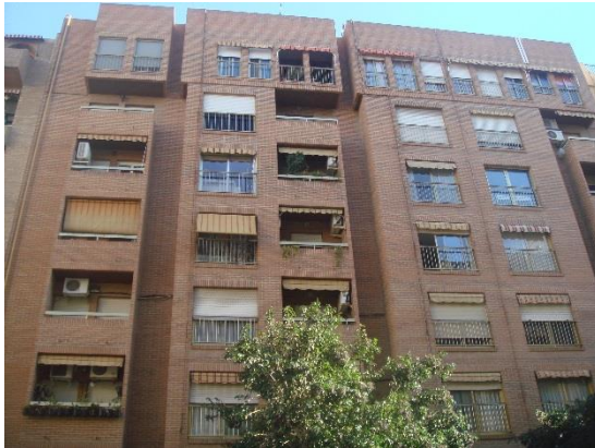
Figura 25. Fachada de ladrillo cerámico visto. 2014. Fuente propia
