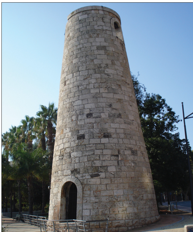
Fig. C5.59 Depósito de agua en la actualidad Producción propia
