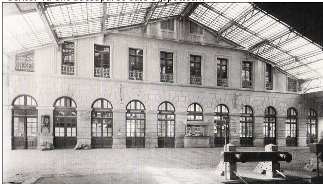
Fig. C4.23 Interior de la Estación. 1945 Fuente: Foro Remember Valencia
