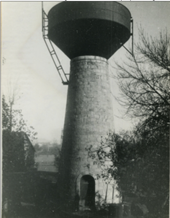
Fig. C4.25 Depósito de agua de los talleres de la Estación Central de Aragón. Fuente: Foro Remember Valencia
