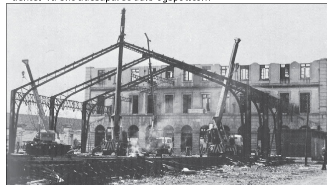
Fig. C4.24 Desmantelamiento de la Estación de Aragón. Año 1974 Fuente: Foro Remember Valencia
