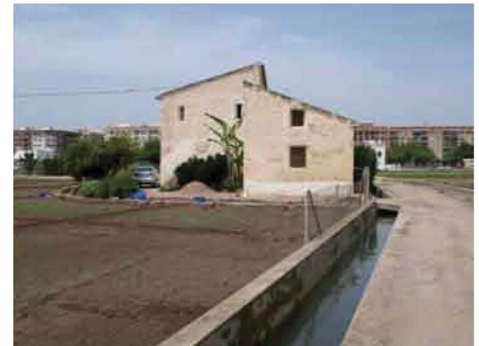
Fig. C5.109 Alquería Requeni EPA_06.07 Fuente: PATPHV
