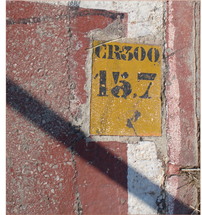
Fig. C5.23 Sañalización en el suelo del CR-300 y punto km Fuente: Producción propia
