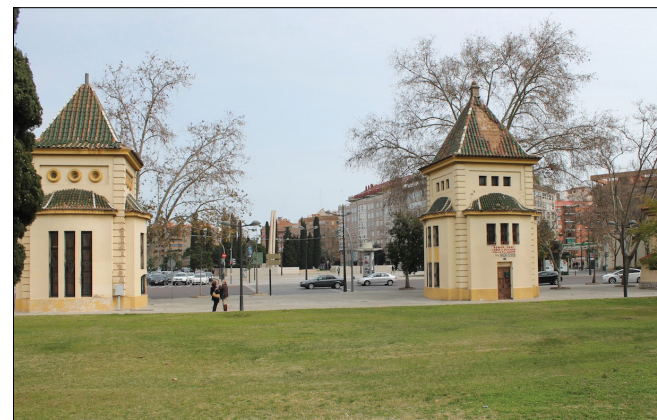
Fig. C4.19 Vista actual del lugar que ocupaba la antigua Estación de Aragón. Fuente: valenciadesaparecida.blogspot.com
