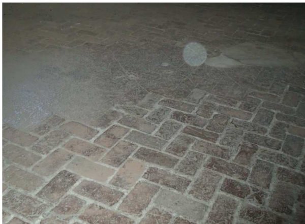
Figura 45. Falta de solería de barro cocido, repuesta con mortero de cemento. Estancia entre la Sala de Armas y la Sala del Cuerpo de Guardia. Mayo 2014. Fotografía particular.
