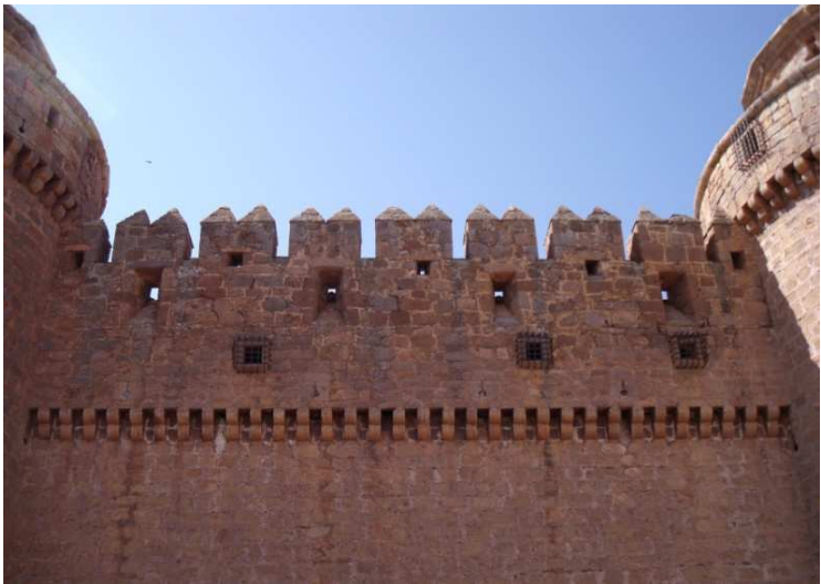
Figura 21. Almenas en la parte superior de la cara norte del Castillo. Junio 2014. Fotografía particular.
