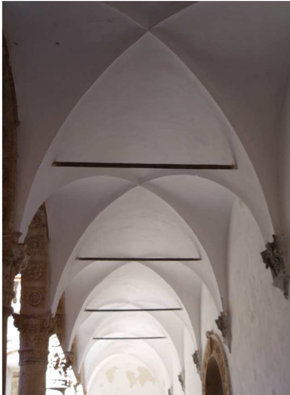
Figura 10. Bóveda de arista arriostrada con tirantes de hierro. Mayo 2014. Fotografía particular.
