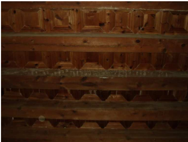
Figura 24. Techo artesonado de madera. Mayo 2014. Fotografía particular.
