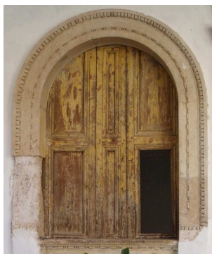
Figura 87. Falta de decoración de piedra caliza en jamba de ventana. Sala del Cuerpo de Guardia. Mayo 2014. Fotografía particular.
