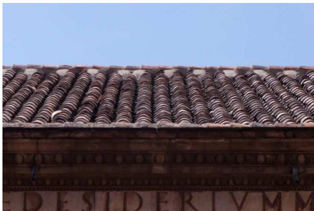
Figura 130. Cubierta de teja cerámica curva. Sala de la justicia. Junio 2014. Fotografía particular.
