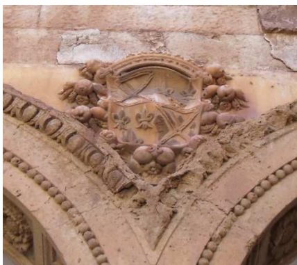
Figura 91. Suciedad en decoración de piedra caliza. Escudo de la familia Fonseca y Mendoza. Galería inferior del patio central. Junio 2014. Fotografía particular.
