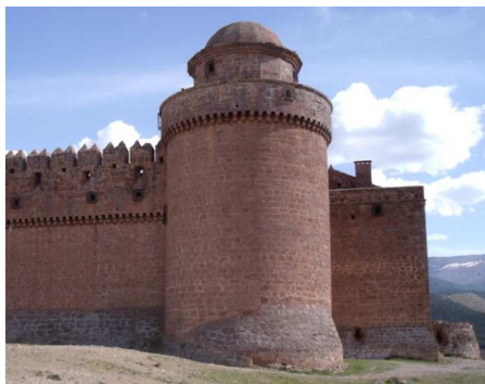
Figura 5. Cubete artillero adosado al Castillo de La Calahorra en la parte derecha de la imagen. Mayo 2014. Fotografía particular.
