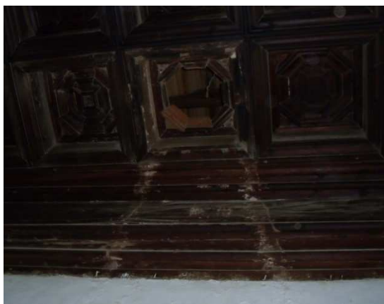
Figura 115. Suciedad y falta de piezas en artesanado. Sala de los Marqueses. Mayo 2014. Fotografía particular.
