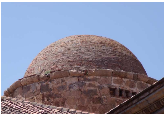
Figura 23. Cúpula de media naranja en la parte superior de cada torre. Junio 2014. Fotografía particular.
