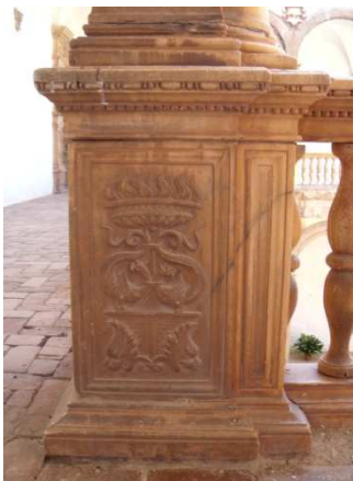
Figura 94. Suciedad en decoración en pedestal de mármol. Galería superior del patio central. Junio 2014. Fotografía particular.
