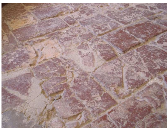
Figura 50. Rotura de solería de barro cocido. Meseta de escalera de acceso a planta primera. Mayo 2014. Fotografía particular.
