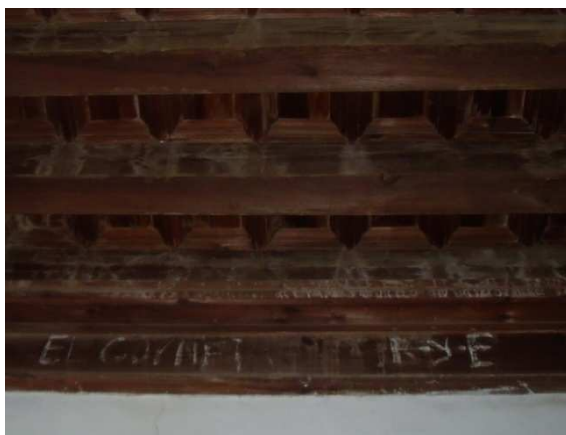
Figura 125. Humedad, suciedad y manchas de pintura en artesanado. Sala de Armas. Mayo 2014. Fotografía particular.
