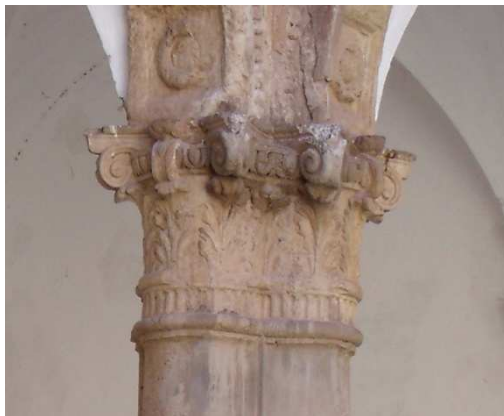
Figura 80. Suciedad en capitel de piedra caliza. Galería inferior del patio central. Mayo 2014. Fotografía particular.
