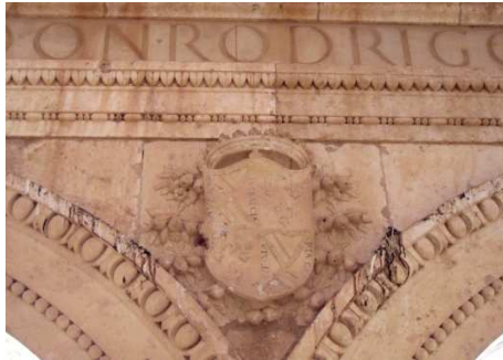
Figura 83. Suciedad provocada por la acción animal. Decoración de piedra caliza en la escalera de acceso a la planta primera. Mayo 2014. Fotografía particular.
