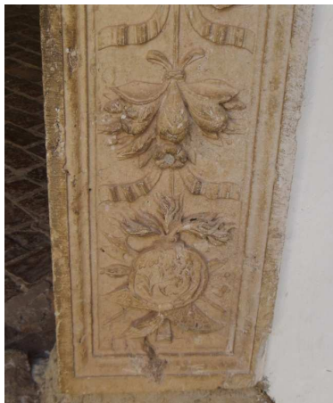
Figura 89. Suciedad en decoración grutesca de piedra caliza. Portada de acceso al patio central. Mayo 2014. Fotografía particular.
