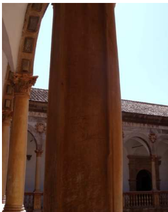
Figura 68. Suciedad y pintadas en columnas de mármol. Galería superior del patio central. Mayo 2014. Fotografía particular.
