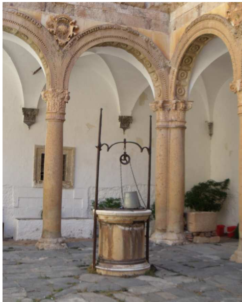
Figura 22. Pozo para extracción de agua del aljibe, situado bajo el patio central. Aljibe de mil metros cúbicos de capacidad. Junio 2014. Fotografía particular.
