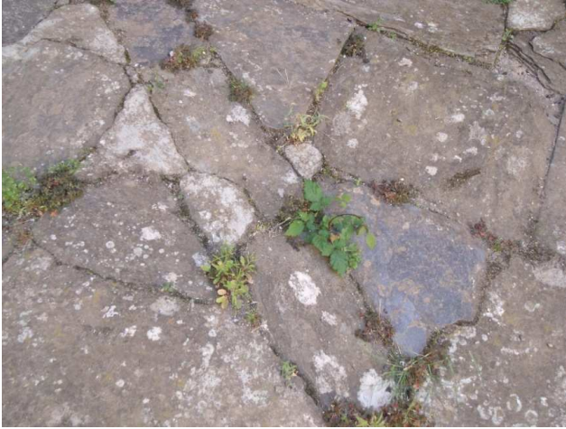
Figura 59. Vegetación en solería de baldosas de piedra. Patio central. Mayo 2014. Fotografía particular.
