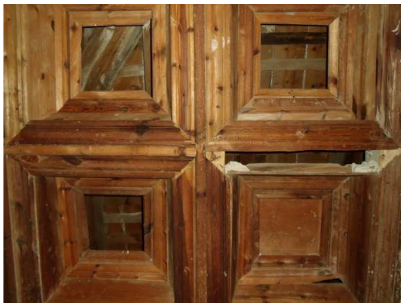
Figura 120. Suciedad y falta de piezas en artesanado. Sala en planta primera. Junio 2014. Fotografía particular.
