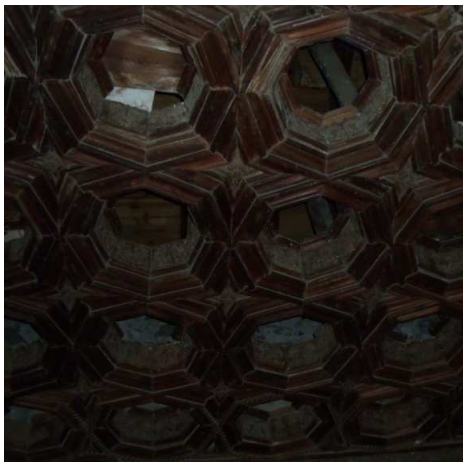
Figura 116. Suciedad y falta de piezas en artesanado. Sala anexa la Sala de los Marqueses. Junio 2014. Fotografía particular.
