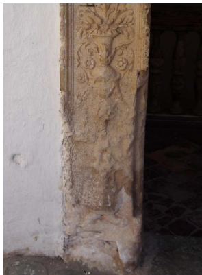
Figura 85. Desgaste del material y manchas de humedad. Decoración grutesca en portada de entrada al patio central. Mayo 2014. Fotografía particular.
