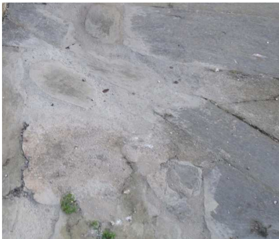
Figura 49. Reparación de solería de piedra. Patio central. Mayo 2014. Fotografía particular.
