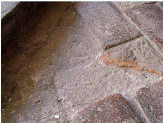
Figura 47. Falta de piezas de solería de barro cocido. Sala Cuerpo de Guardia. Mayo 2014. Fotografía particular.
