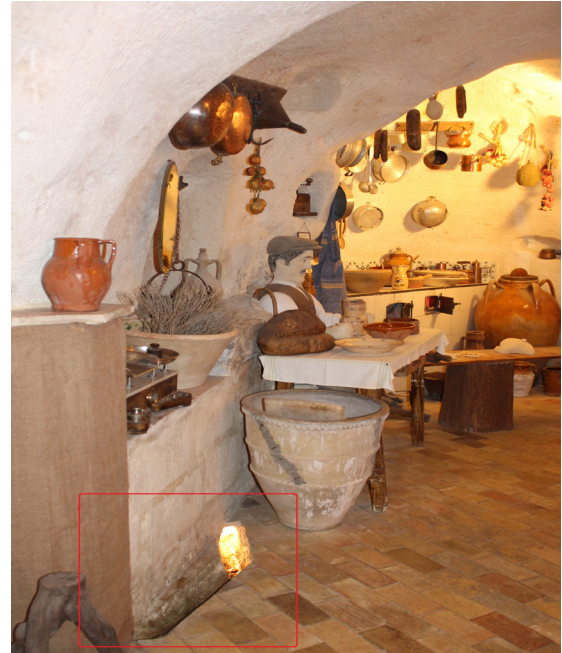
Figura 62, Sistema de recogida y canalización de agua en el interior de un cueva (2014). Fuente: Imagen de autor
