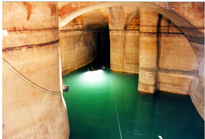
Figura 140, fotografía tomada durante los trabajos de inspección de los buzos (2014) Fuente: recursos electrónicos.
