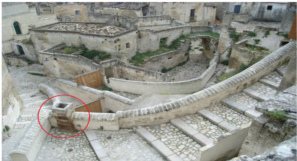
Figura 109, ejemplo de hueco de ventilación que desemboca al pavimento de la disposición de las calles. (2014) Fuente: recursos electrónicos.
