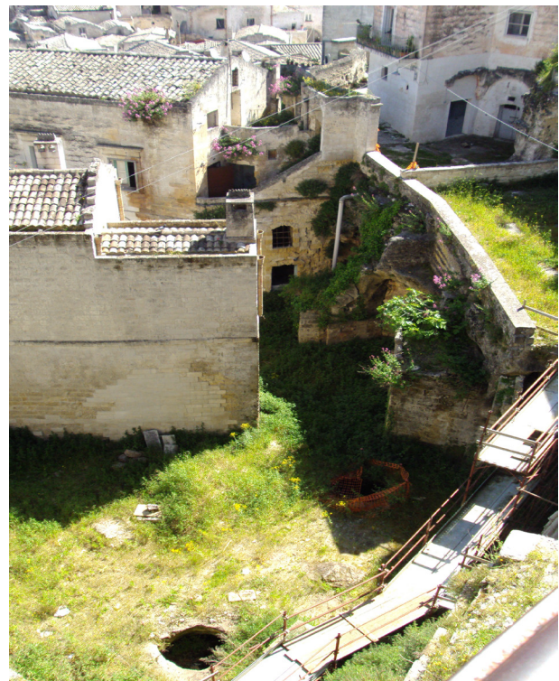
Figura 55, Localización de dos pozos o aljibes pendientes de restauración. (2014) Imagen de autor.
