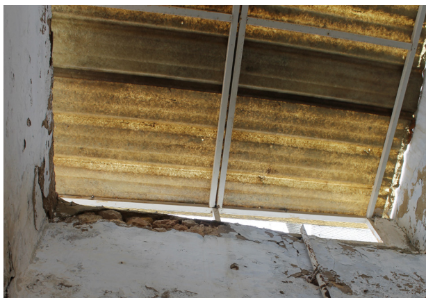
Figura 116, lucernario del patio de luces (2014). Fuente: imagen de autor.
