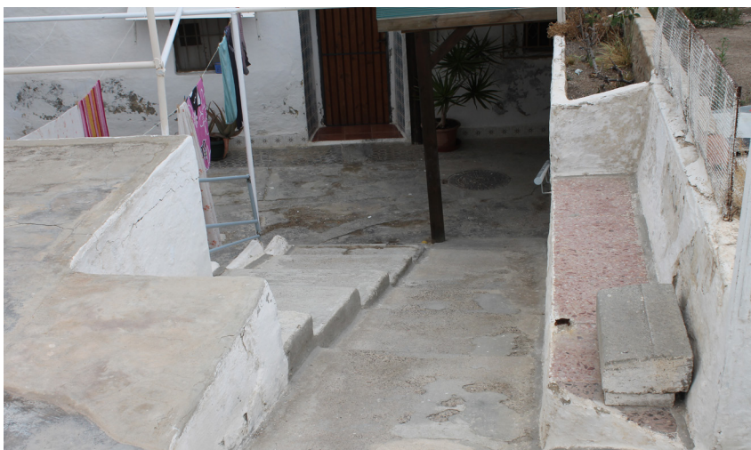
Figura 121, rampa escalonada de acceso a la casa cueva (2014). Fuente: imagen de autor
