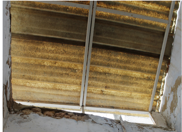
Figura 128, cubierta de lucernario en vivienda cueva (2014) Fuente: imagen de autor
