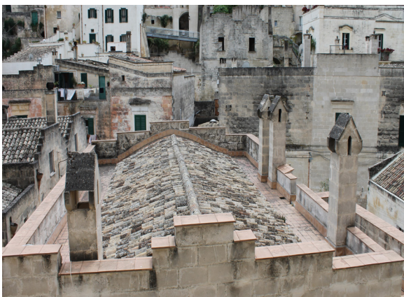
Figura 58, cubierta de un Lamione (2014). Fuente: Imagen de autor
