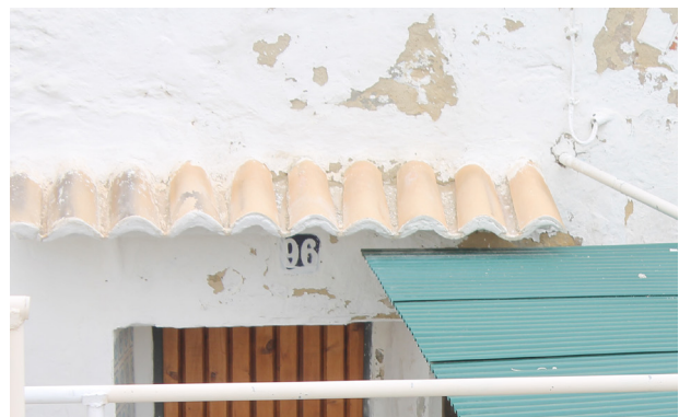
Figura 129, alero sobre la puerta de acceso (2014). Fuente: imagen de autor
