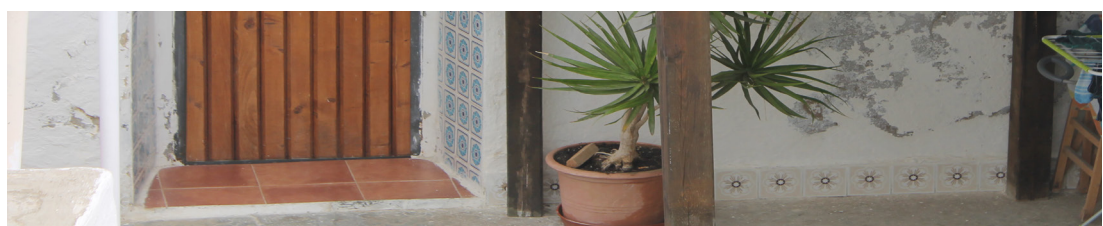
Figura 130, baldosas cerámicas de la fachada de acceso (2014) Fuente: imagen de autor
