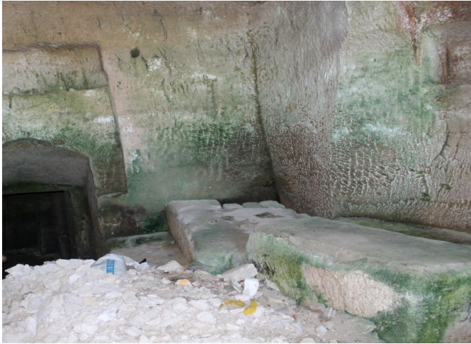
Figura 61, Sistema de recogida y canalización de agua por condensación y filtración en el interior en una cueva deshabitada. (2014). Fuente: Imagen de autor
