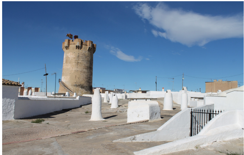
Figura 135, chimeneas de ventilación en cuevas de la zona de La Torre. (2014) Fuente: imagen de autor.
