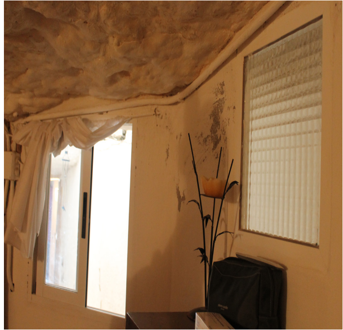
Figura 119, ventanas que comunican el dormitorio principal con el lucernario del patio de luces (2014). Fuente: imagen de autor.
