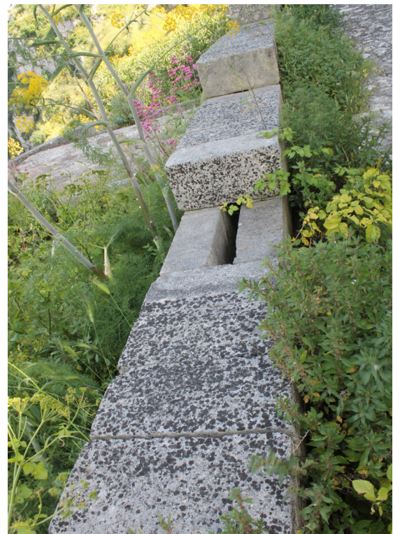
Figura 64, canalización de agua. Actualmente sin uso por estar ubicada en una zona deshabitada. (2014). Fuente: Imagen de autor
