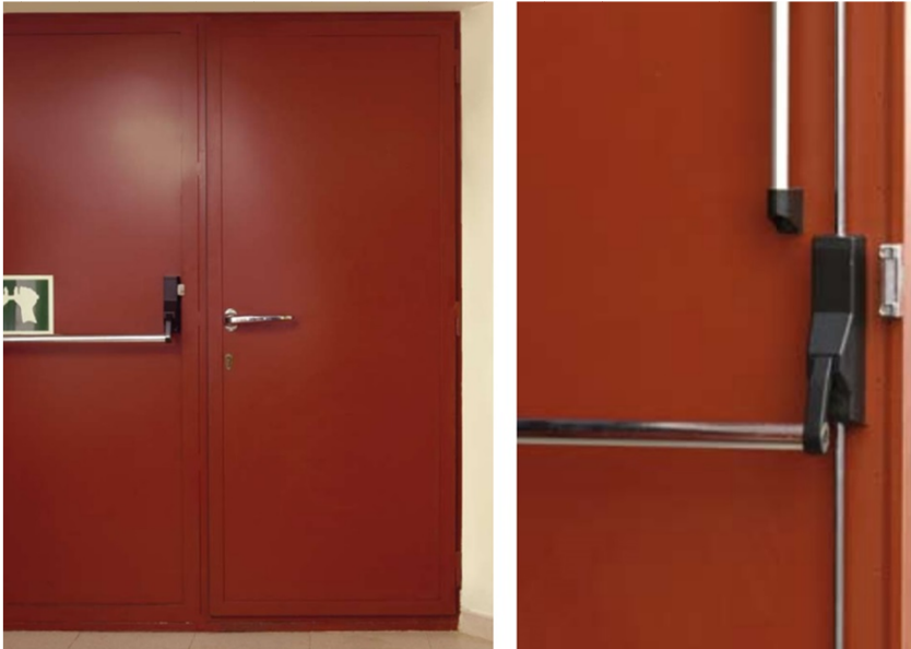
Figura 51. Puerta Notson PM2 con antipánico
