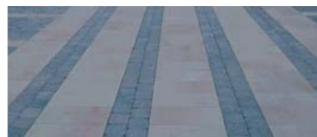
En los paseos centrales de acceso a la universidad, el que conecta con las viviendas y el paralelo a la Lonja de Pescadores que atraviesa toda la parcela, se dispone de una combinación de adoquín, siguiendo el sistema de las calles peatonales del pueblo, combinado con losa de hormigón.
