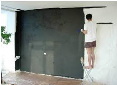
Fig.19b Aplicación de la pintura de apantallamiento de la radiación.
