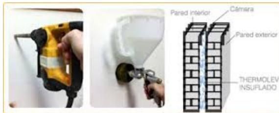
Fig.26 Proceso esquemático del insuflado en cámara de vivienda. 2014.
