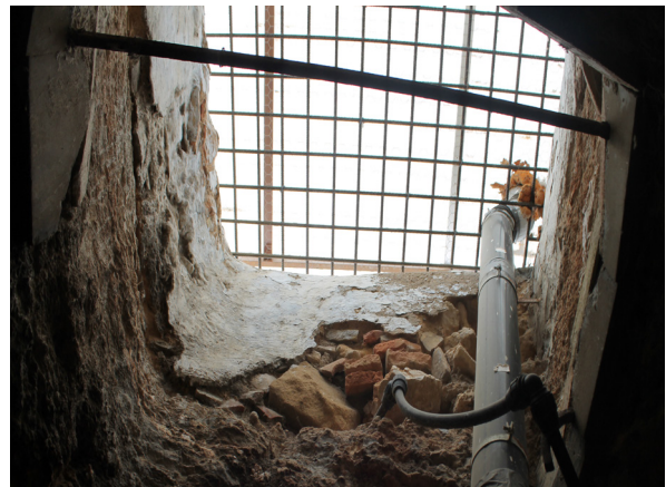
Figura 131, visualización de una sección del terreno que conforma la cubierta de la casa-cueva, dónde se observa el espesor de la roca, y sobre esta una serie de piedras y tierra compactada. (2014) Imagen de autor.
