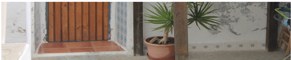
Figura 107, baldosas cerámicas de la fachada de acceso (2014) Fuente: imagen de autor
