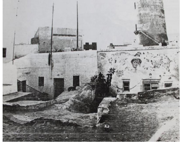
Figura 9, vista de dos casas cueva en una de las zonas de concentración de este tipo de viviendas en el municipio de Paterna, en concreto en la zona de la Torre en 1960 (2014). Fuente: registro de fichas del archivo del Ayuntamiento de Paterna
