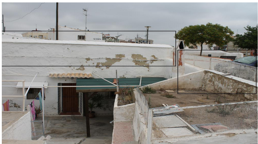
Figura 102, antepechos de la plaza de acceso (2014) Fuente: imagen de autor
