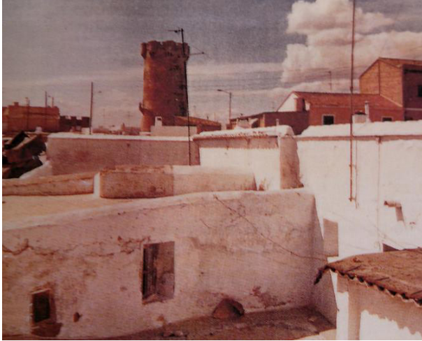
Figura 8, vistas generales de una de las zonas de casas cueva de Paterna, en concreto en la zona de la Torre en 1980 (2014). Fuente: publicación “Villa de Paterna. Historia y toponimia” de José Escrich Lázaro que muestra las
