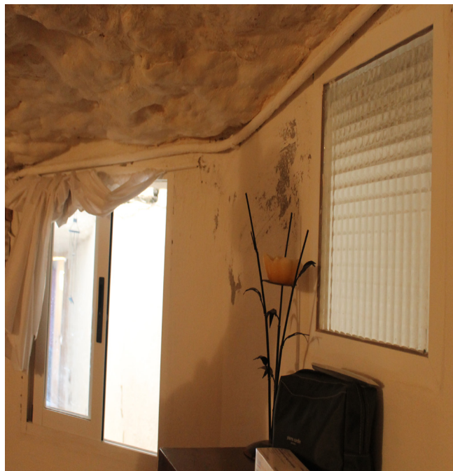
Figura 95, ventanas que comunican el dormitorio principal con el lucernario del patio de luces (2014). Fuente: imagen de autor.
