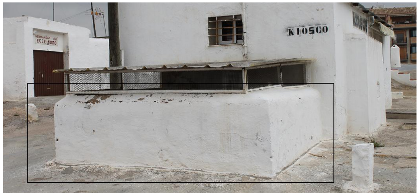
Figura 101, antepechos de los huecos cenitales (2014) Fuente: imagen de autor
