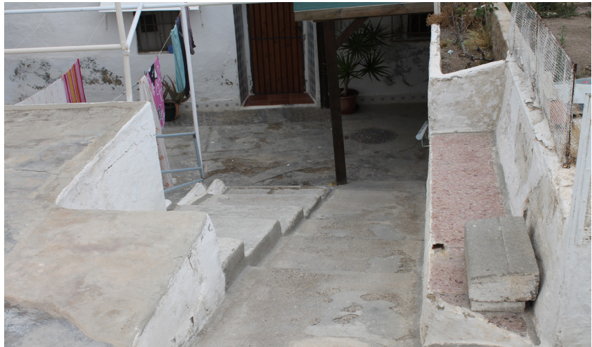
Figura 97, rampa escalonada de acceso a la casa cueva (2014). Fuente: imagen de autor
