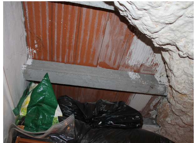
Figura 134, Refuerzo bajo la zona del quiosco. (2014) Imagen de autor.
