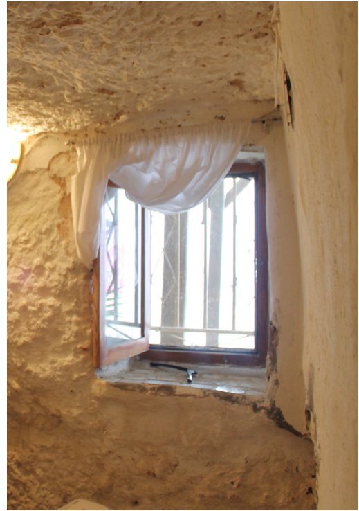
Figura 91, ventana que tiene comunicación directa con el dormitorio secundario (2014). Fuente: imagen de autor
