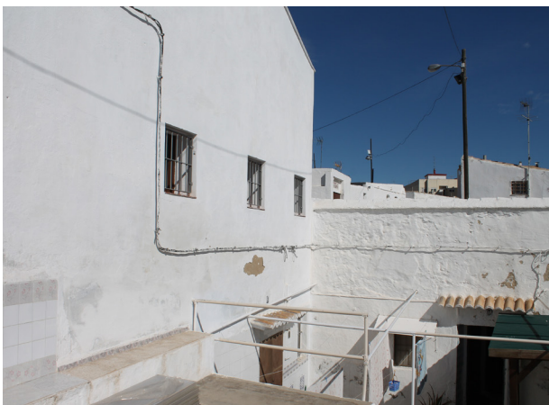
Figura 98, construcción anexa sobre la casa cueva vecina (2014) Fuente: imagen de autor
