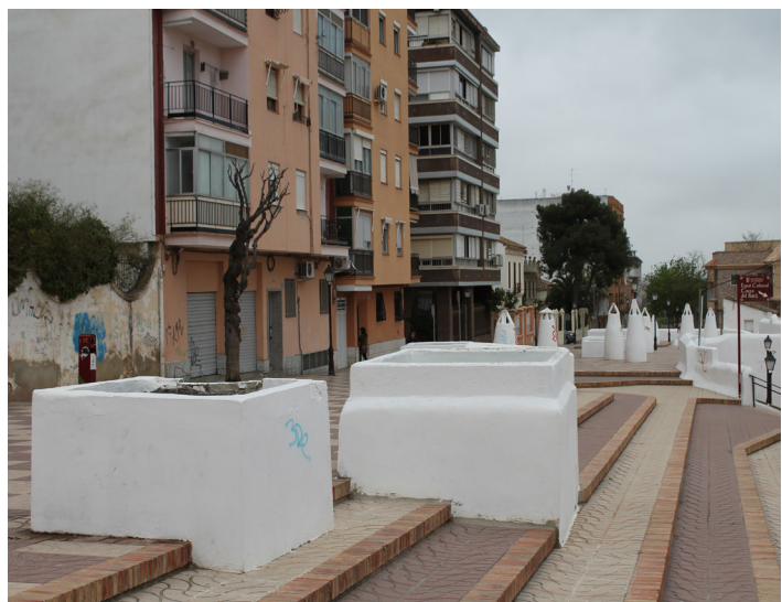
Figura 108, Huecos de lucernarios sin cubierta. (2014) Fuente: Imagen de autor.
