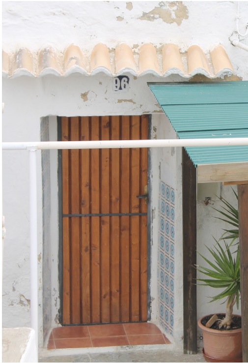
Figura 90, puerta acceso que tiene comunicación directa con el pasillo longitudinal (2014). Fuente: imagen de autor
