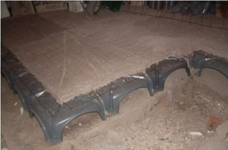
*Imagen 15.* Ejecución de forjado sanitario con módulos de PP
