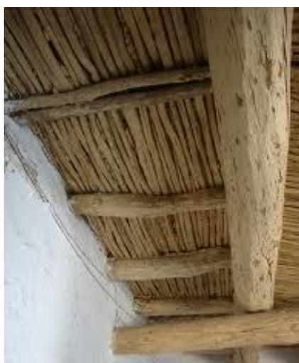
*Imagen 18.* Forjado de madera compuesto de rollizos y vigas.
