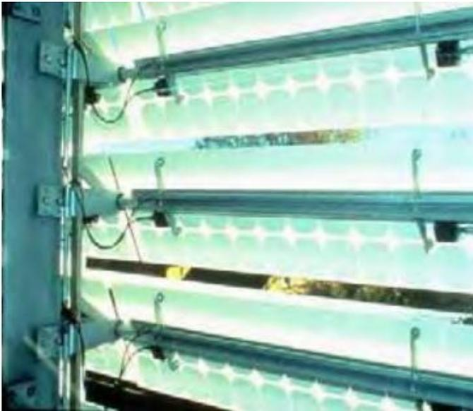
Imagen 27. Entramado de lamas orientables con placas fotovoltaicas integradas.
