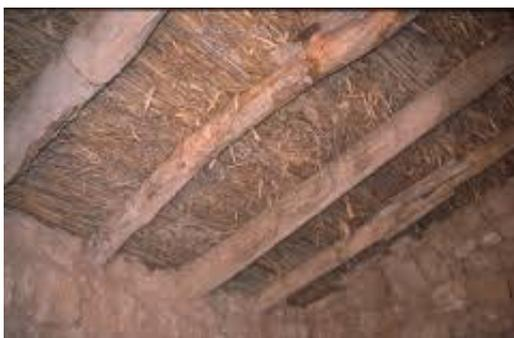
*Imagen 17.* Forjado de madera compuesto de vigas y cañizo
