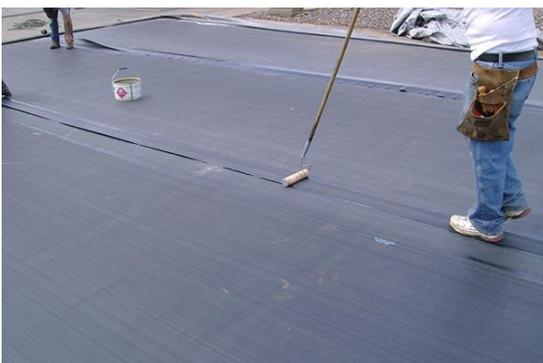
Imagen 24. Puesta en obra de lámina impermeable EPDM
