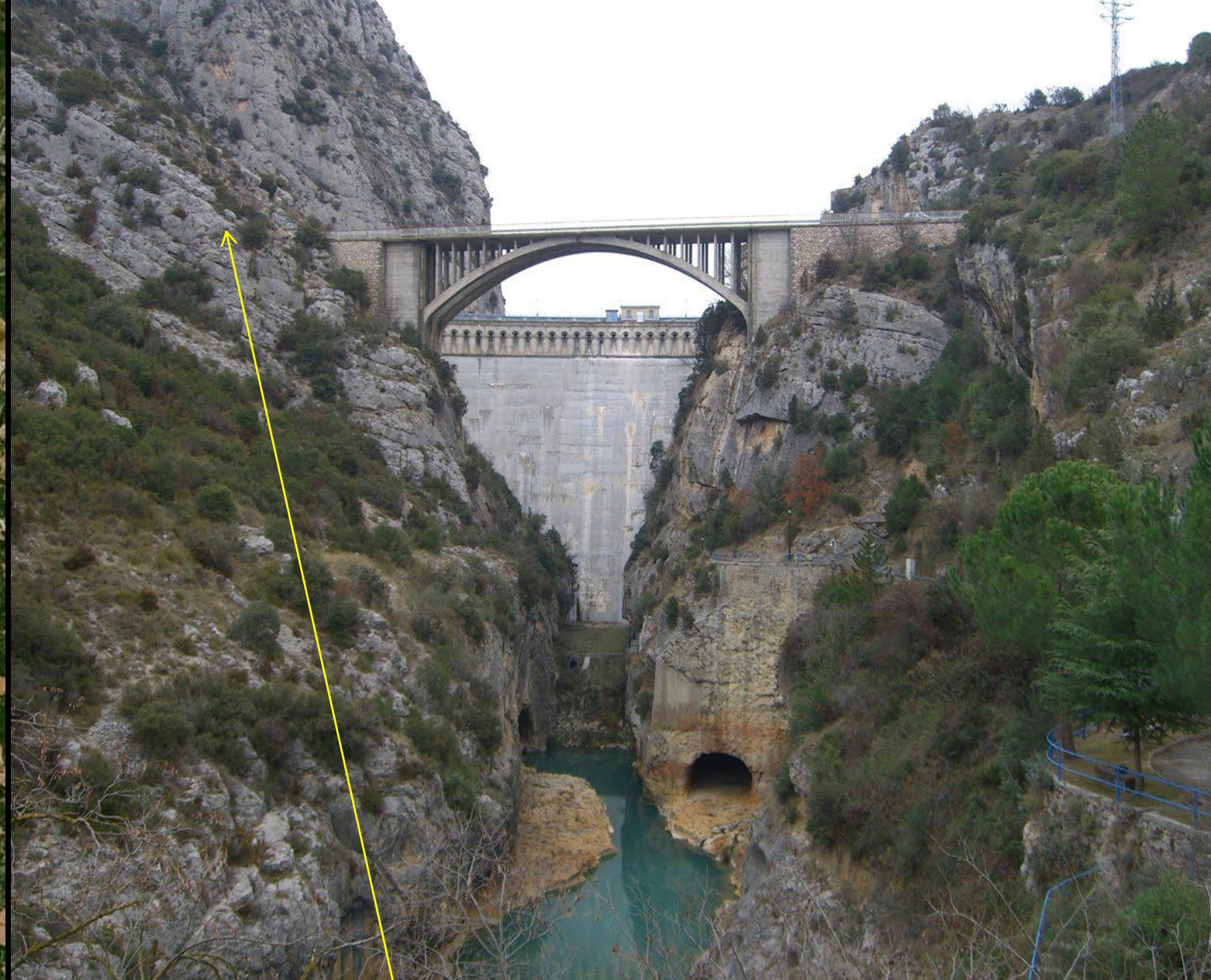
Embalse de Barasona, Graus, Huesca. N Centro E Hoja de Fonz. S Centro E de la de Graus. Cerrada en calizas del Cretácico Sup. (por José Luis Echeverría-Google)
