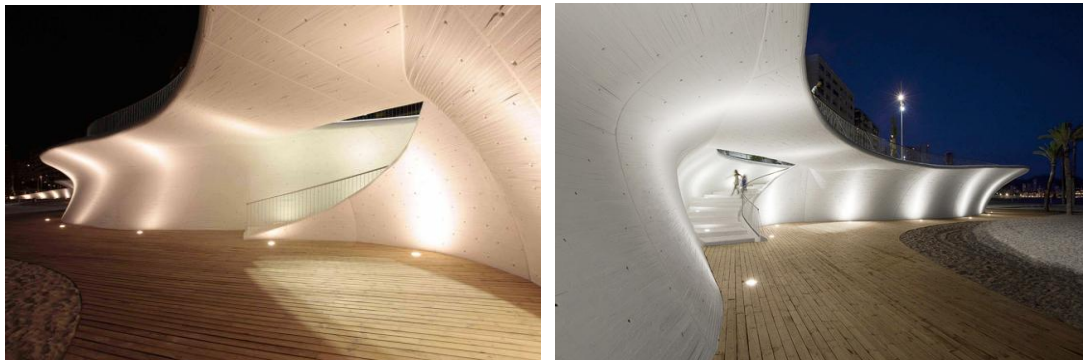
Imagen 3. Este sistema de iluminación dirigida desde abajo acentúa el ritmo de los volúmenes, el contraste de los materiales y la calidez del pavimento. Playa de Poniente en Benidorm, proyecto de Carlos Ferrater.
