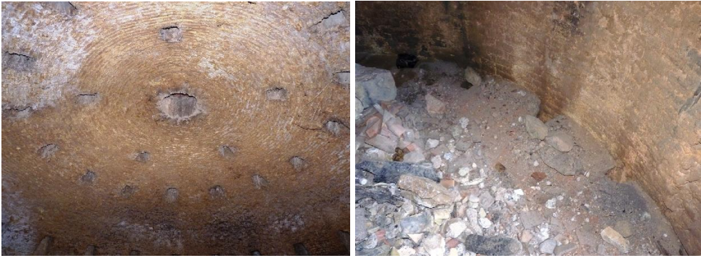
Techo o "lluna" y suelo o "dau", interior de un horno del barrio industrial de Ribesalbes
