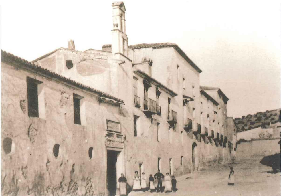
Fábrica del Conde de Aranda, fachada principal, principios s. XX
