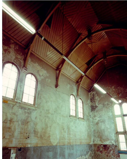
Fig. 51 Edificio en restauración. Fuente www.project-westergasfabriek.nl
