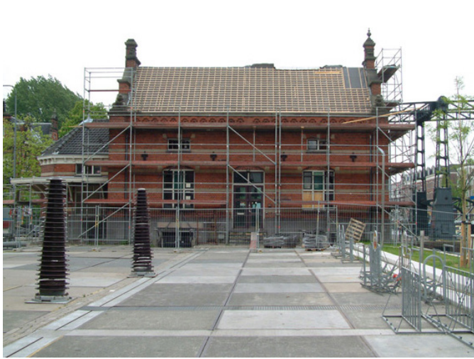
Fig. 50 Edificio en restauración. Fuente www.project-westergasfabriek.nl
