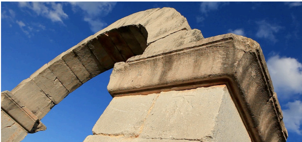
Fig. 68 Arco de Cabanes. Castellón. Fotografía: Ignacio Yusim
