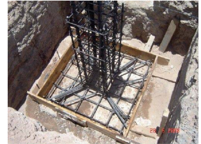
^^ Execució sabata cuadrada.
