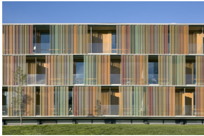
_ Casa B2,Vaillo i Irigaray . façana de lames i gelosia ceràmiques
