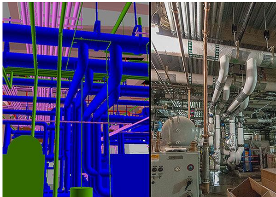
Ilustración 14. Comparación instalaciones reales con Navisworks. 2012. Facilities Princeton University.
