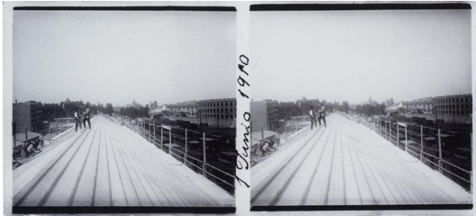
Fig. 15.60. Demetrio Ribes, 1910. Cubierta del ala derecha de la Estación del Norte. Tablero con listones de madera listo para recibir la teja. Placa de vidrio al gelatino-bromuro, 6 x 13 cm (Ribes, 2007:292) © Colección Guillot-Ribes
