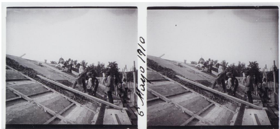
Fig. 15.58. Demetrio Ribes, 1910. Cubierta del ala derecha de la Estación del Norte. Bóvedillas de ladrillo, relleno y enfoscado de cemento. Placa de vidrio al gelatino-bromuro, 6 x 13 cm (Ribes, 2007:290) © Colección Guillot-Ribes
