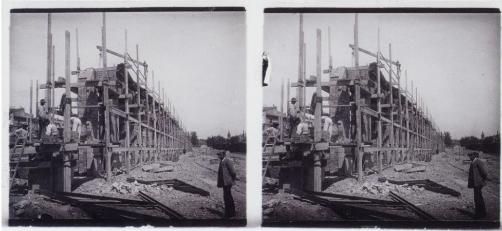
Fig. 15.54. Demetrio Ribes, ca.1910. Construcción de los muros del ala derecha del edificio de viajeros de la Estación del Norte. Valencia. Placa de vidrio al gelatino-bromuro, 6 x 13 cm (Ribes, 2007:288) © Colección Guillot-Ribes
