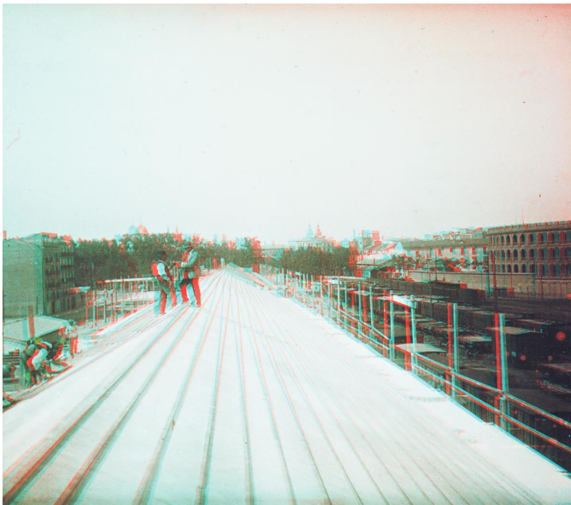
Fig. 15.61. Versión en anaglifo creada para el catálogo (Ribes, 2007:293). En esta vista puede observarse, al fondo y a la derecha, pegado a la plaza de Toros, la boca de entrada de Trenes a la antigua estación, que se encontraba ubicada en la actual Plaza del Ayuntamiento.
