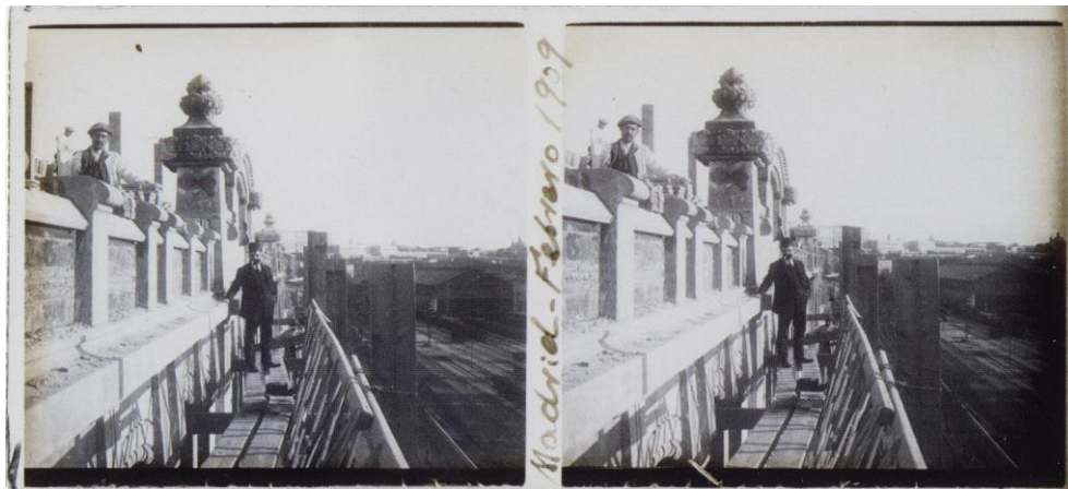
Fig. 15.50. Anónimo, 1909. Demetrio Ribes sobre el andamio en la coronación del edificio de oficinas para la Estación Príncipe Pío . Madrid 1909. Placa de vidrio al gelatino-bromuro, 6 x 13 cm (Ribes,2007:280) © Colección Guillot-Ribes
