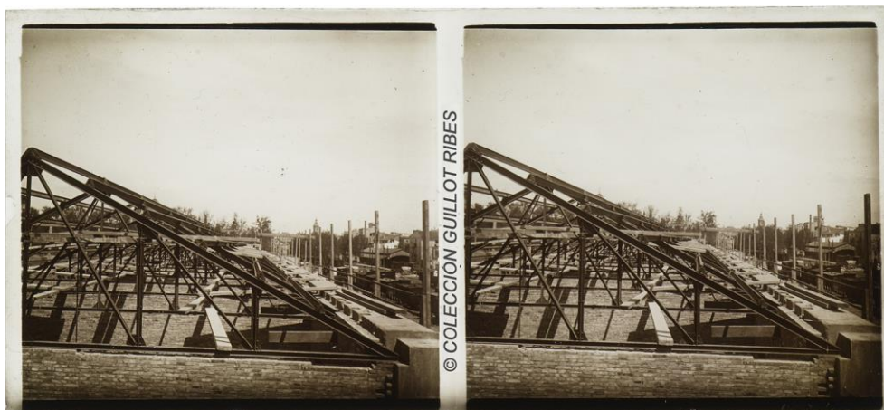
Fig. 15.56. Demetrio Ribes, 1910. Celosía metálica para la cubrición del ala derecha de la Estación del Norte. Valencia. Placa de vidrio al gelatino-bromuro, 6 x 13 cm © Colección Guillot-Ribes
