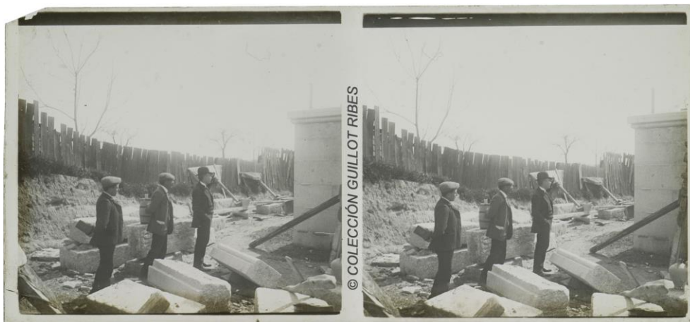
Fig. 15.52. Demetrio Ribes, ca.1909. Vista inédita de la visita al taller de cantería en la que pueden verse tallados las piezas para los zócalos. Placa de vidrio al gelatino-bromuro, 6 x 13 cm © Colección Guillot-Ribes
