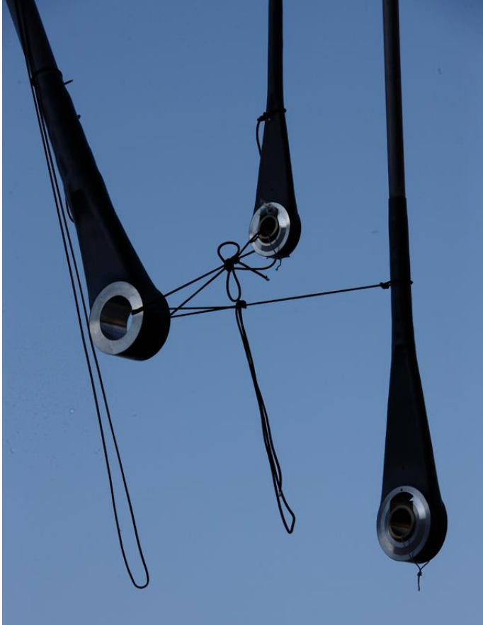
Figura 2.2: Cables totalmente terminados.
