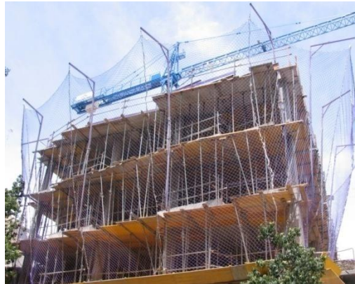
Fig. 2.5 Proceso de cimbrado y descimbrado
