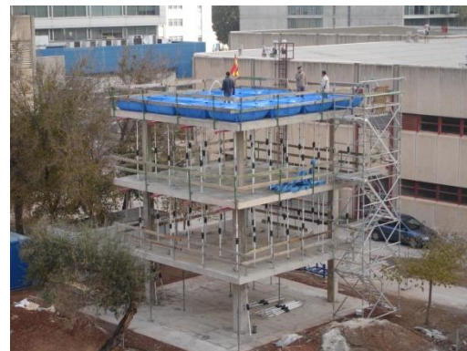
Fig. 4.9 Proceso constructivo día “24”
