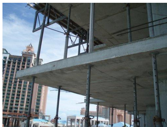
Fig. 2.6 Proceso de cimbrado, recimbrado, descimbrado
