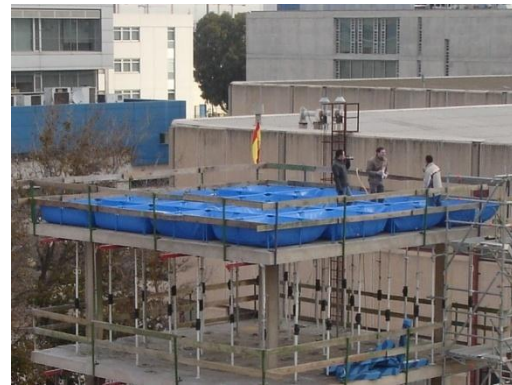
Fig. 4.10 Proceso constructivo día “25”
