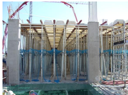
Fig. 6.4 Proceso constructivo día “7”
