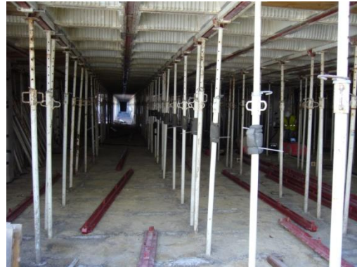
Fig. 6.3 Proceso constructivo día “3”
