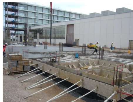
Fig. 6.2 Proceso constructivo día “0”
