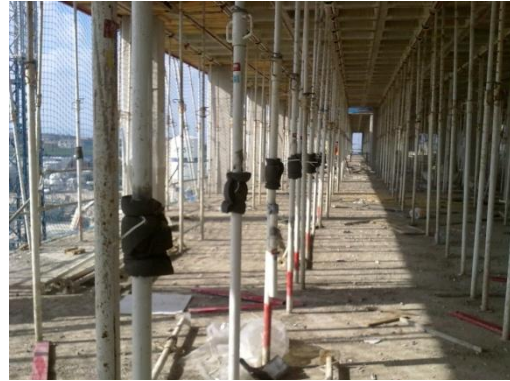
Fig. 6.8 Proceso constructivo día “17”
