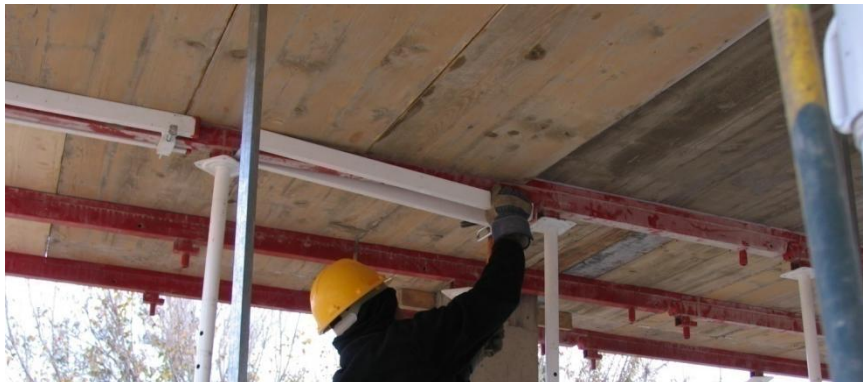
Fig. 4.14 Extracción del basculante de las sopandas principales
