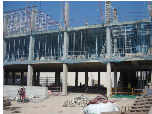
Fig. 6.9 Proceso constructivo día “18”
