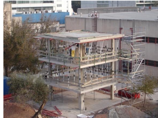
Fig. 4.8 Proceso constructivo día “20”
