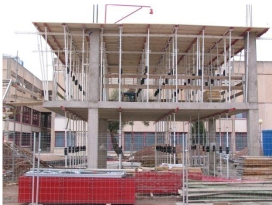
Fig. 2.7 Proceso de cimbrado, clareado y descimbrado
