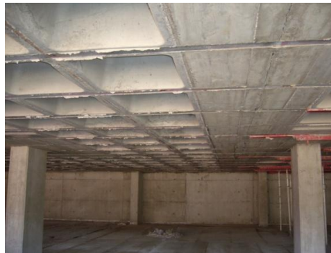
Fig. 6.6 Proceso constructivo día "11"
