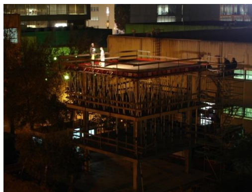
Fig. 4.7 Proceso constructivo día “17”
