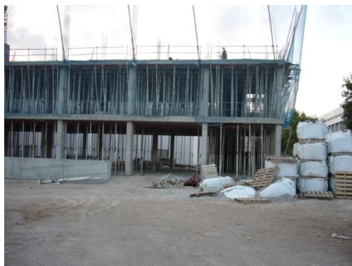
Fig. 6.7 Proceso constructivo día "14"
