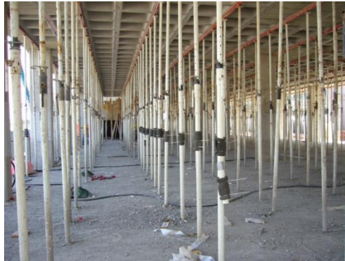
Fig. 6.5 Proceso constructivo día "10"
