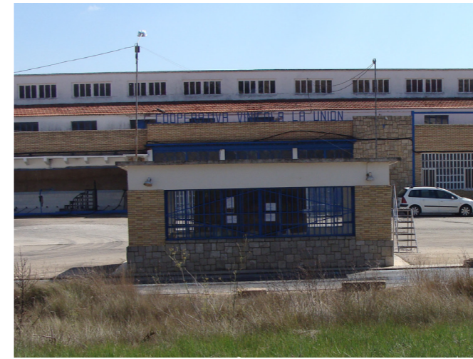
Caseta de pesaje previo
