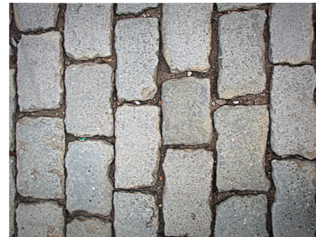
Pavimentos exteriores adoquines granito
