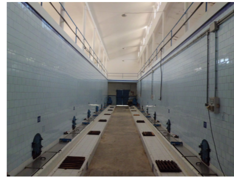
Preexistencia, zona depósitos PB
