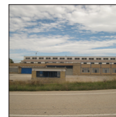
1. Bodega Coop. La Unión
