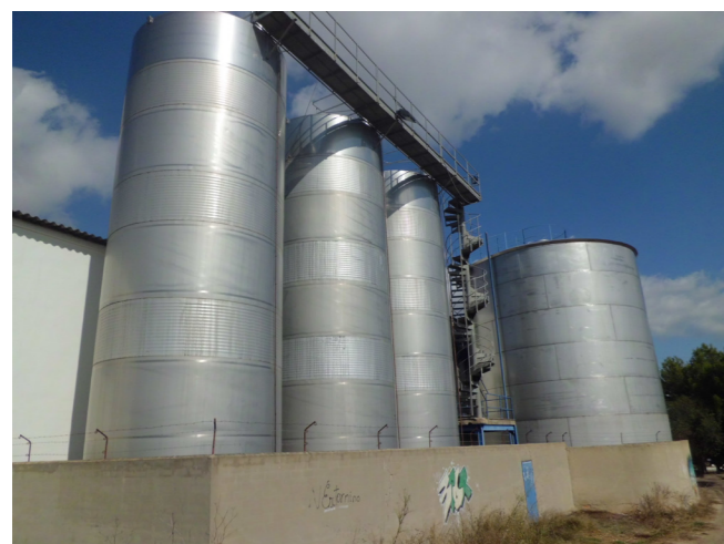
Depósitos exteriores acero
