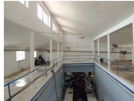
Preexistencia, zona depósitos P1
