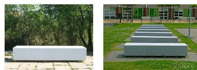
Banco de hormigón armado. Sus características formales y geometría pura lo convierten en un elemento y en un hito individual que ordena los espacios según el ritmo de agregación. Materializado en piedra artificial, este prisma de volumen compacto se apoya sobre el terreno mediante un zócalo rebajado que salva la exactitud geométrica y al mismo tiempo lo hace levitante.
