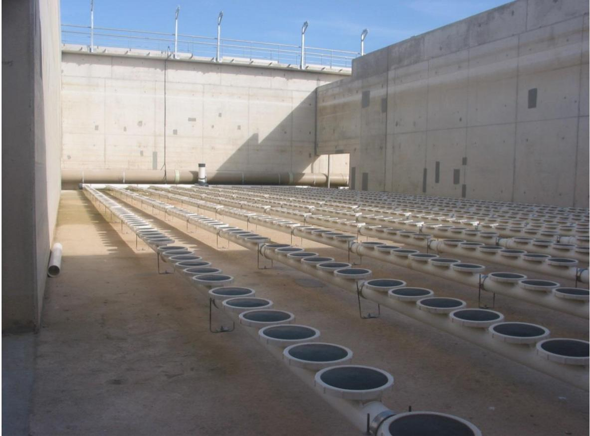
*Figura 53: Imagen instalación red de difusores en un reactor biológico*
