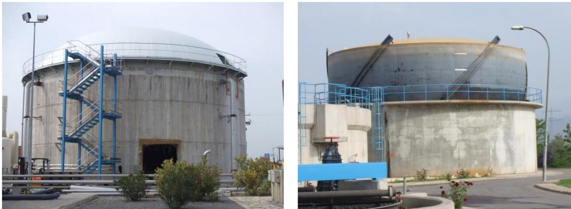
Figura 15 y 16: Digestor de fangos y gasómetro de una EDAR de tratamiento convencional
