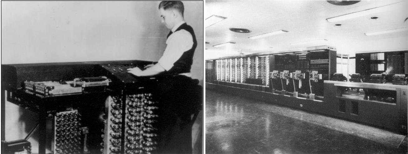
Figura 3: Computador ABC (izquierda) y Mark I (derecha). En el primero se pueden apreciar las válvulas de vacío en la parte inferior. En el segundo destacan los acumuladores en el extremo izquierdo, junto a las lectoras de cinta perforada en la parte central.
