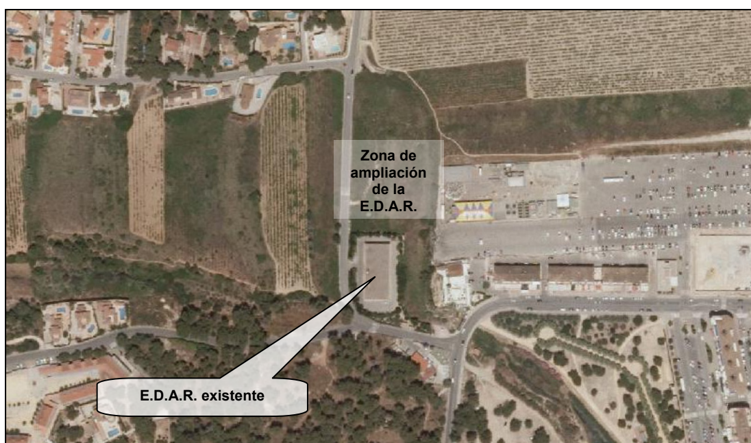
FIGURA 26. Emplazamiento de la zona de ampliación de la E.D.A.R. de Moraira. (GENERALITAT VALENCIANA. CONSELLERIA D' INFRAESTRUCTURES, TERRITORI I MEDI AMBIENT, 2014).
