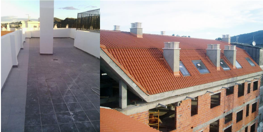
Fig 19. Cubierta plana transitable (dcha) y cubierta inclinada de teja curva (izda) ( www.eshor.com )
