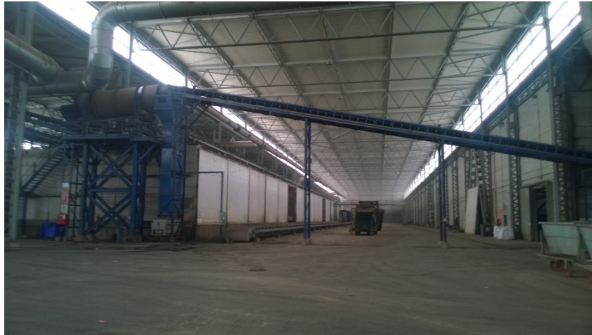
Imagen 21. Transporte a túneles.
