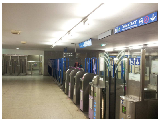
Imatge 46: Pòrtics d'eixida des de la part en direcció de Porte de Versailles i accés Transilien i RER A
