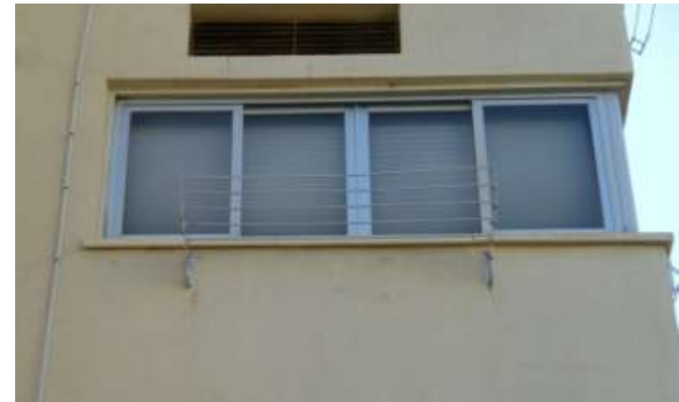
Figura 63 Fuente propia: Dintel fachada posterior
