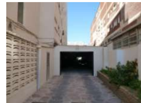
Figura 75 Fuente propia: Aparcamiento
