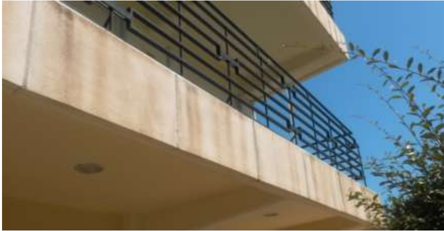
Figura 60 Fuente propia :Barandilla hierro forjado
