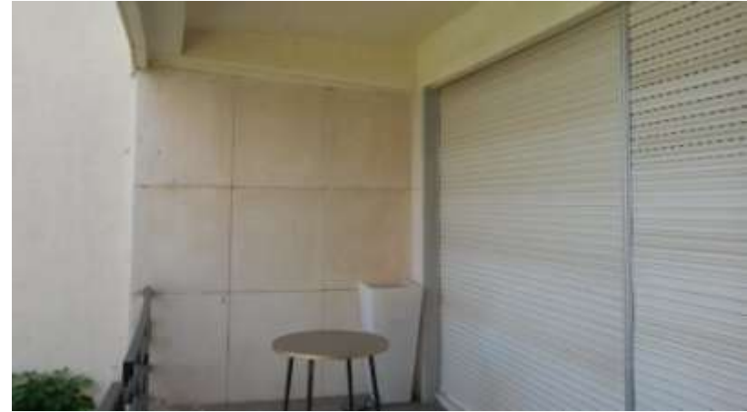
Figura 59 Fuente propia: Carpintería metálica exterior
