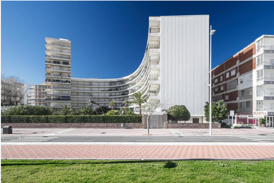
Fotografía de la fachada principal
