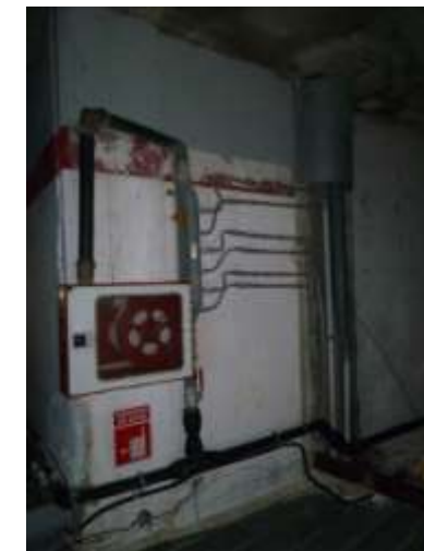
Figura 38 Fuente propia Cuadro de luces e instalación trifásica interior vivienda.
