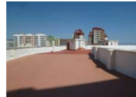
Figura 33 Fuente propia: Cubierta edificio.
