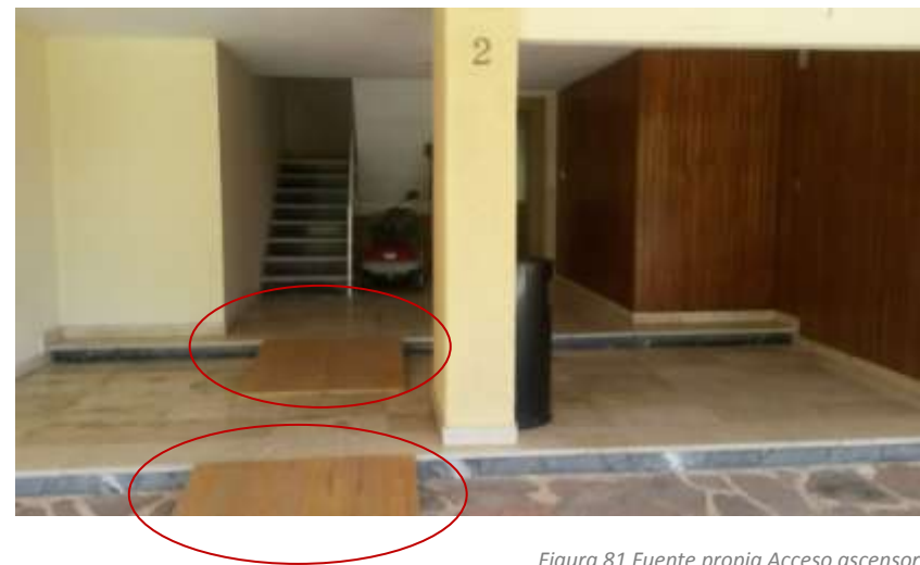
Figura 81 Fuente propia Acceso ascensor
