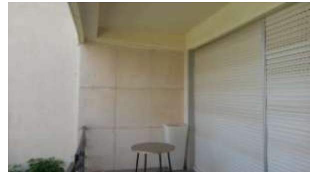
Figura 35 Fuente propia: Persiana y carpintería, vista exterior e interior.
