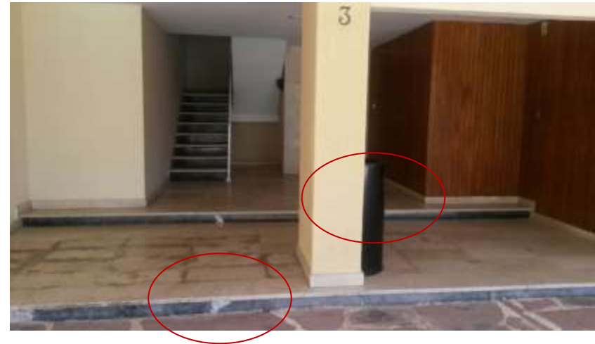
Figura 80 Fuente propia Acceso ascensor
