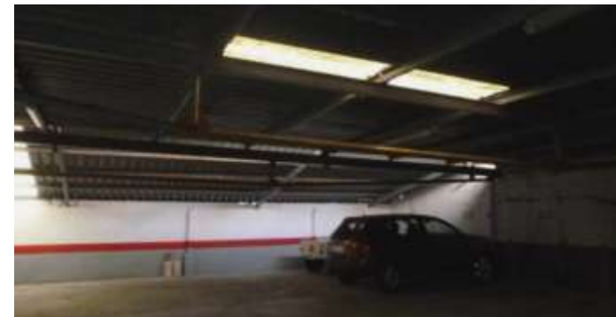
Figura 54 Fuente propia: Aparcamiento edificio
