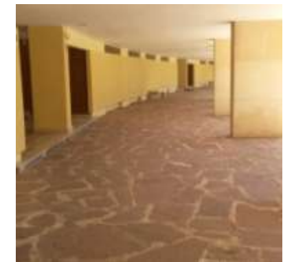
Figura 85 Fuente propia, pasillo de comunicación
