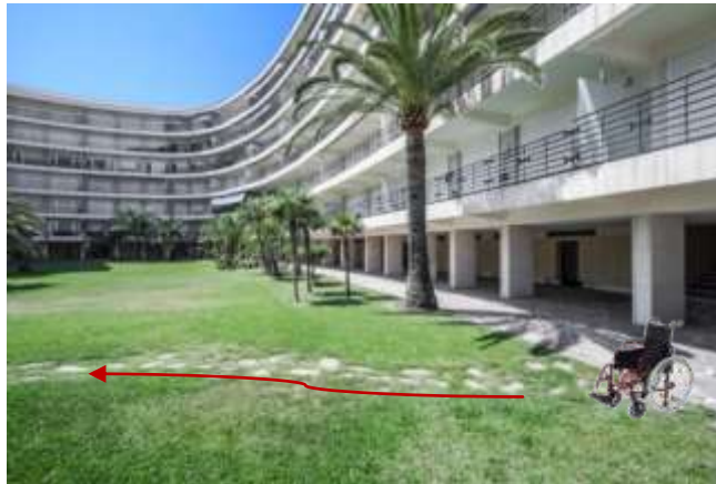
Ilustración 78 Fuente propia: Acceso actual a la piscina.
