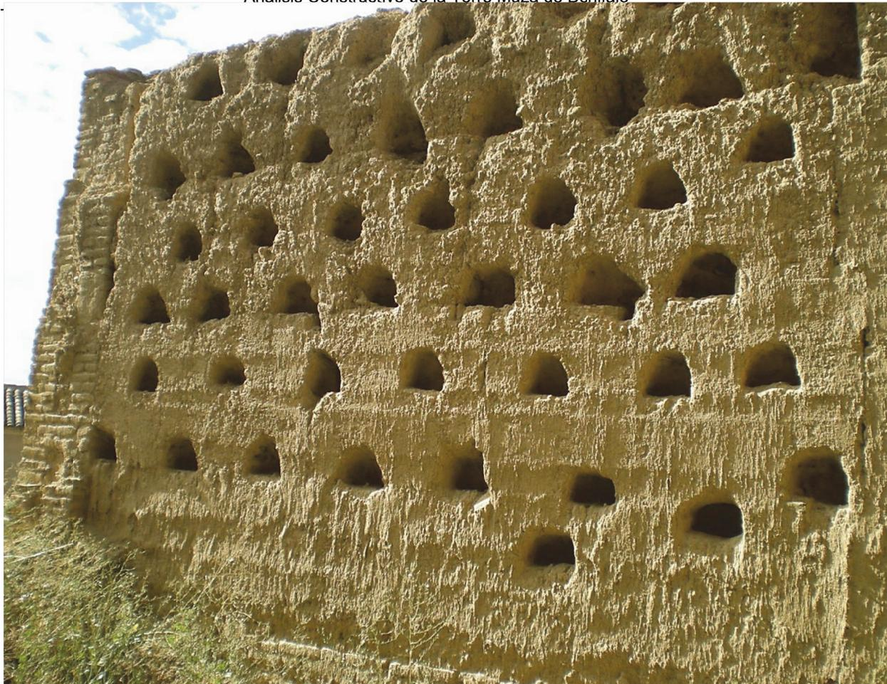
Imagen 122 Muro de tapia en los restos de una torre de origen árabe, con oquedades excavadas en su parte interior. En este caso las perforaciones se han realizado al “tresbolillo”, evitando la correspondencia vertical dado que el muro es de tierra, a diferencia del muro de la torre Muza, realizado con tapia de cal y canto. Moral de la Reina, Tierra de Campos, Valladolid.
