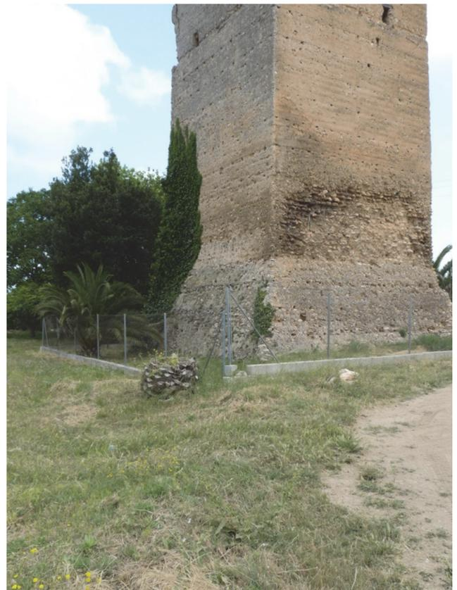
Imagen 54 Dibujo esquemático de los elementos básicos de la torre defensiva de Bofilla (Betera) según A. Bazzana y P. Guichard, indicando la existencia de unos elementos previos. (Imagen 55). En el caso de la Torre Muza el montículo y desnivel existente en la torre en la parte SO, que se evidencia por la diferencia de cota de la valla próxima a la torre no se debe a esto sino a posteriores rellenos de tierra para el cultivo.
