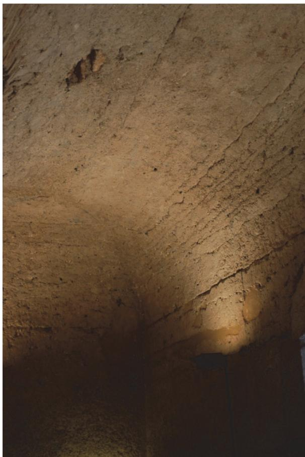
Imagen 56 Torre de la Plaza de Benifaió. Detalle de las bóvedas interiores de cañon y en la parte derecha se pueden apreciar las juntas verticales entre las tapialadas.
