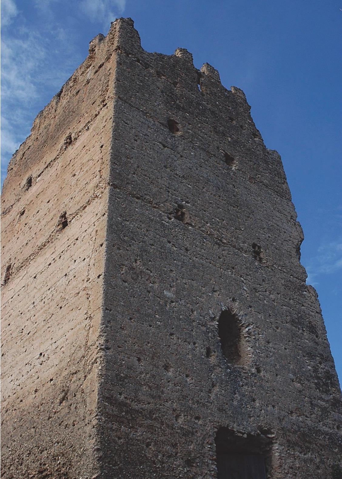
Imagen 81 Vista parcial de la torre y los huecos principales en las caras NE y SE, así como las huellas de los cadalsos en las esquinas de la torre.
