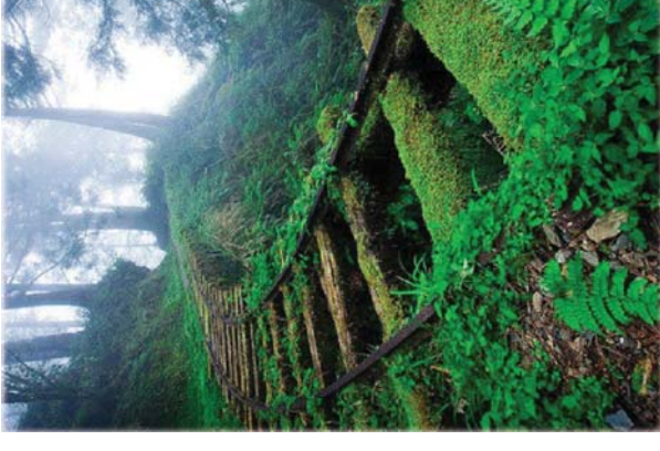
Imagen 3.1 Vía ferrocarril abandonada
