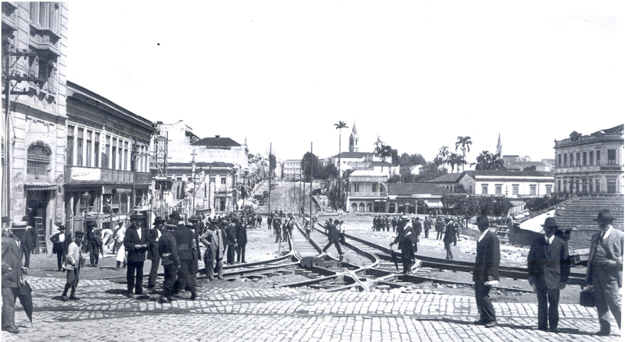
Ilustración 15. Construcción del sistema de raíles para bondes eléctricos en el largo de São Joao, alrededor de 1912. Fuente: A Cidade que não Pode Para , Cândido Malta et al.
