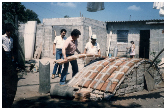
Fig. 126: Carlos González Lobo durante la prefabricación de dovelas para bóvedas reforzadas México. Archivo de Carlos González Lobo (González, H. 2002).
