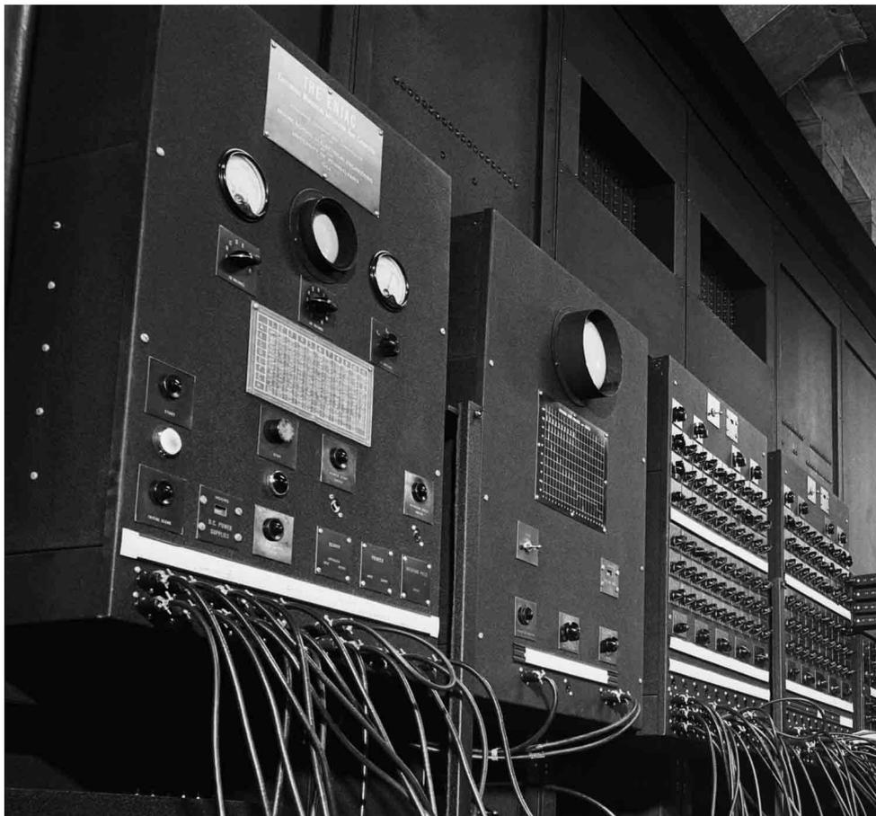
Imagen 22 – Vista de la unidad de inicio, ciclos y el programador maestro
