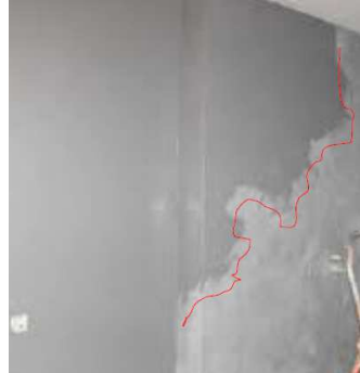
Figura 16. Preparación paño para continuación al día siguiente. 2014. Guía aplicación Sika.
