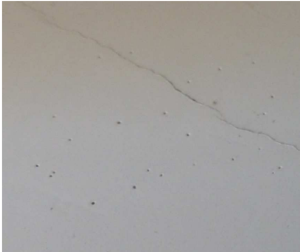
Figura 37. Picaduras debido a burbujas de aire. 2014. Inmobles Xúquer.
