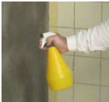
Figura 8. Humectación capa base. 2014. Fichas técnicas Sika.
