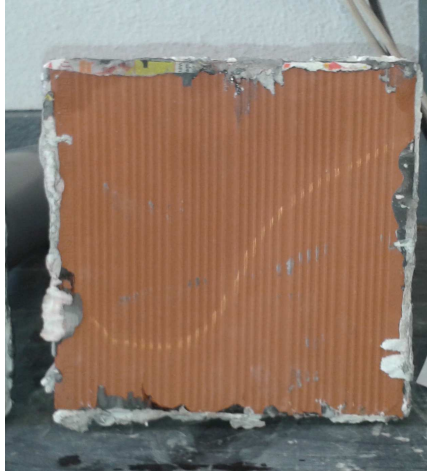
Figura 34. Humedad sobre la muestra 1. 2014. Imagen propia
