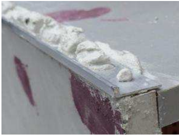
Figura 21. Perfil puesto en obra. 2014.TopCiment.
