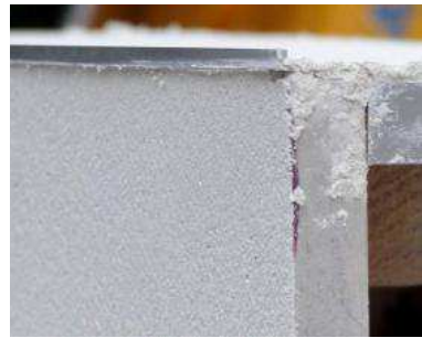
Figura 20. Perfil para peldaño puesto en obra. 2014. TopCiment.
