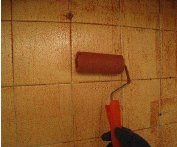
Figura 2. Imprimación sobre alicatado. 2014. Fichas técnicas Sika.
