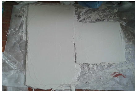
Figura 7. Aplicación capa regularización . 2014. Imagen propia.
