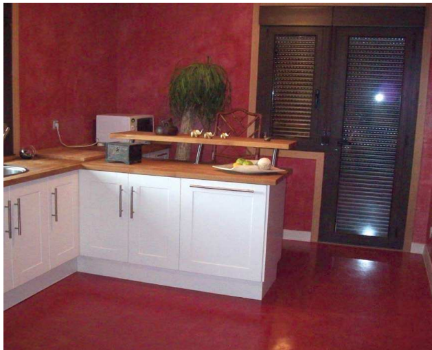
Figura 9. Microcemento sobre suelo y paredes. 2014. Catálogo Sika.
