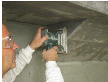
Figura 17. Eliminación de irregularidades. 2014. Guía aplicación Sika.
