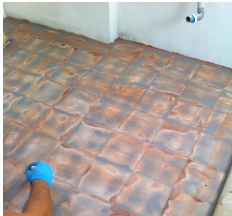
Figura 18. Preparación de suelo, lijado y capa de imprimación. 2014. Pinturas Jose Antonio García.
