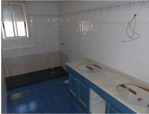
Figura 12. Preparación salidas de desagües e instalación eléctrica. 2014. Inmobles Xúquer.
