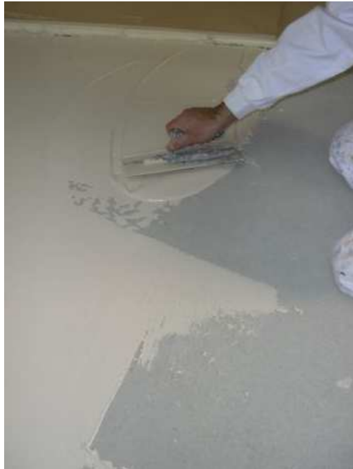
Figura 3. Aplicación capa base. 2014. Fichas técnicas TopCiment.
