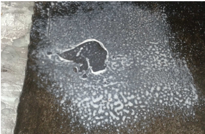
Figura 36. Levantamiento de capa de sellado sin esperar el tiempo de secado. 2014. Imagen propia.
