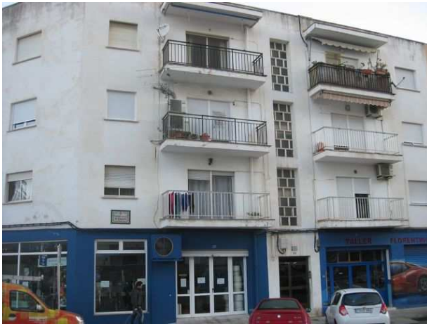
Ilustración 24. Edificio tipología plurifamiliar mayor de 4 viviendas. Fuente propia.
