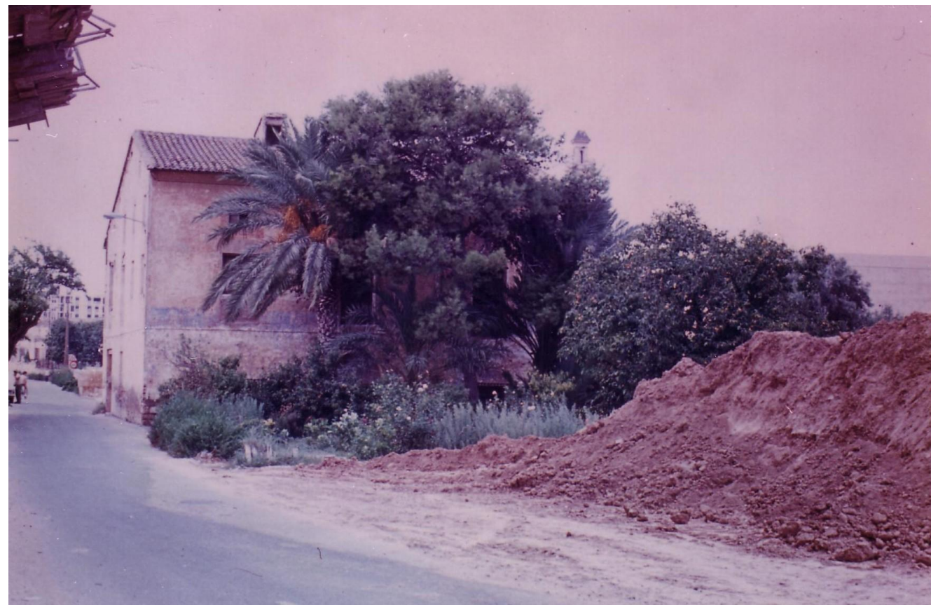
Figura 69. Entorno de la Alquería antes de los trabajos de urbanización. Fuente: Carmen Cárcel García.
