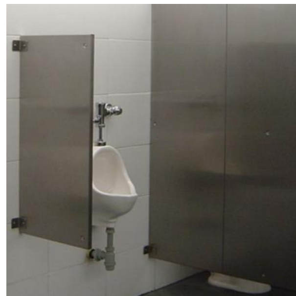
Figura 124: Acabado de compartimentación. 2014. Fuente: www.solucionesmodulareshn.com
