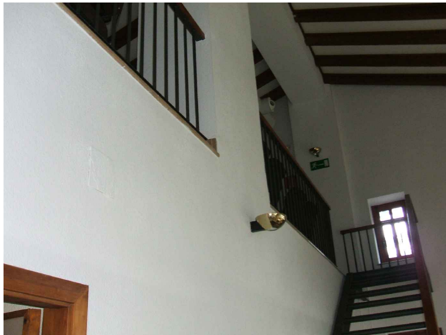
Figura 198. Desembarco de escalera de acceso a la sala de estar desde Oficinas II. 2014. Fuente: elaboración propia.
