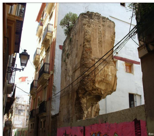
Figura 11. Restos de muralla en la c/Salinas, barrio del Carmen. 2012. Fuente: www.jdiezarnal.com
