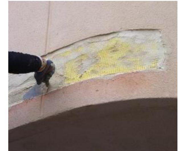
Figura 139. Intervención con lámina mallatex en la azotea de un edificio. 2014. Fuente: www.rehabilitacionedificios.net
