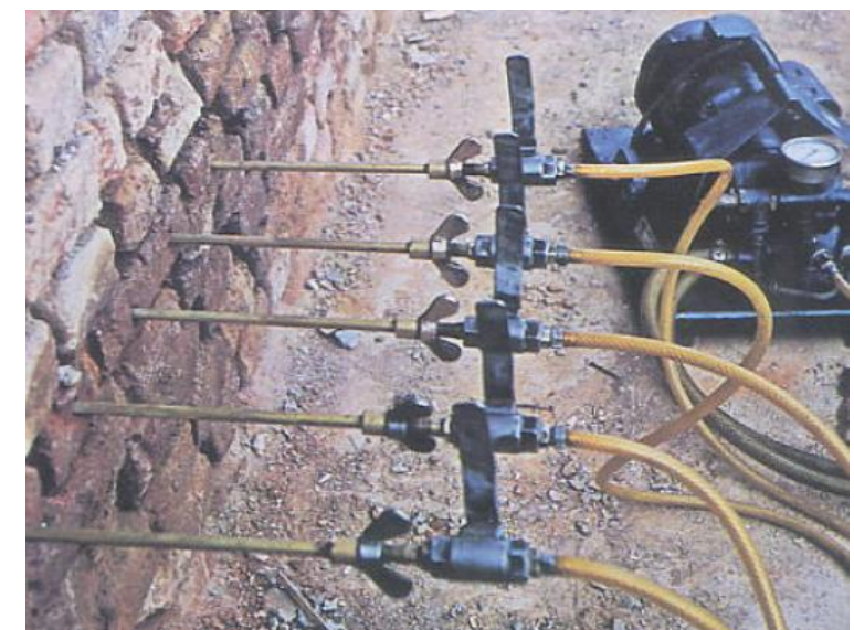
Figura 135. Aplicación de la barrera química sobre un muro de mampostería. 2014. Fuente: Apuntes de la asignatura Construcción VI.
