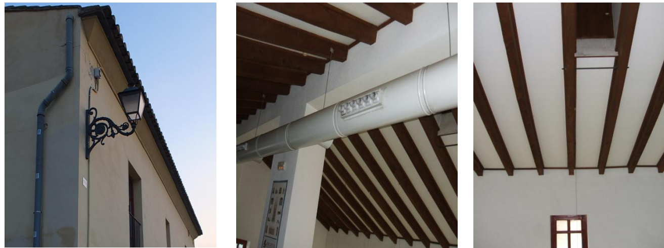
Figuras 83, 84 y 85. Vistas exterior e interiores de la cubierta (Izquierda, alero posterior y bajante pluvial; centro, encuentro de los faldones; derecha, ventana de acceso). 2014. Fuente: elaboración propia.
