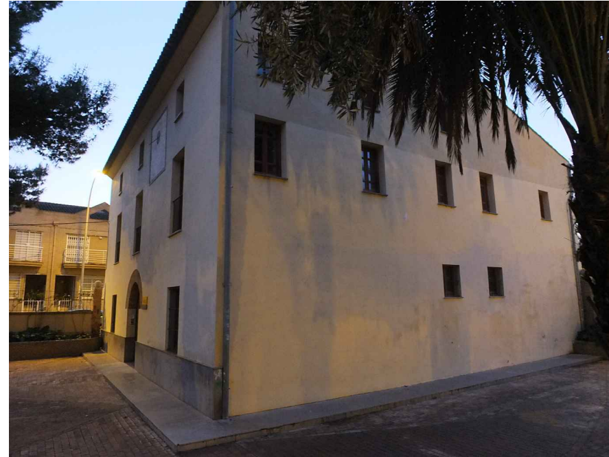
Figura 160. Esquina entre las fachadas principal (SE) y lateral derecho (NE). 2014. Fuente: elaboración propia.
