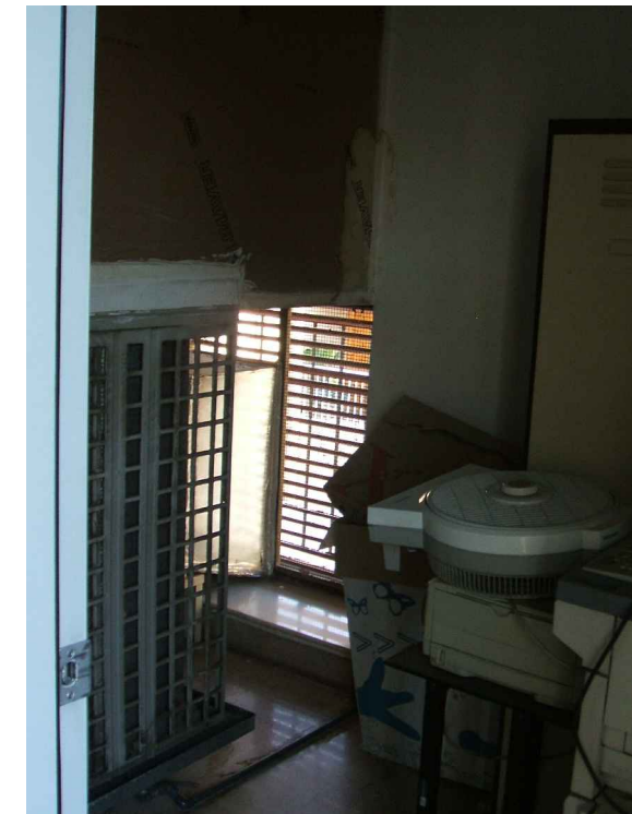
Figura 194. Cuarto de instalaciones. 2014. Fuente: elaboración propia.
