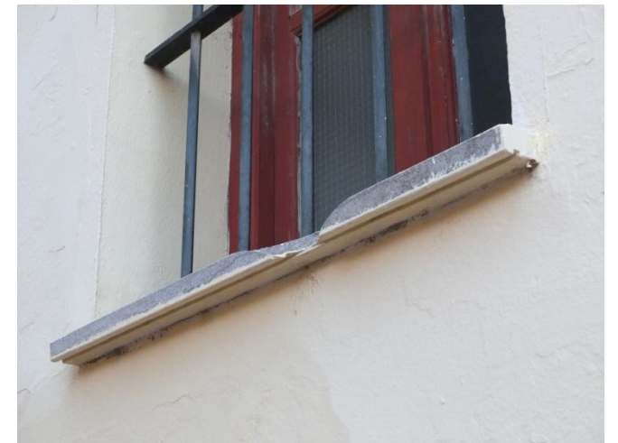
Figuras 145 y 146. Fractura de porción de alfeizar. 2014. Fuente: elaboración propia.
