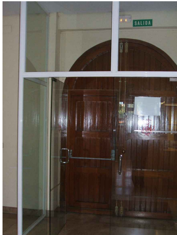
Figura 165. Entrada al edificio vista desde el interior. 2014. Fuente: elaboración propia.
